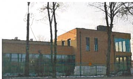
Przebudowa Szkoły Podstawowej w Słomczynie
