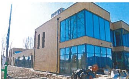
Przebudowa Szkoły Podstawowej w Słomczynie
