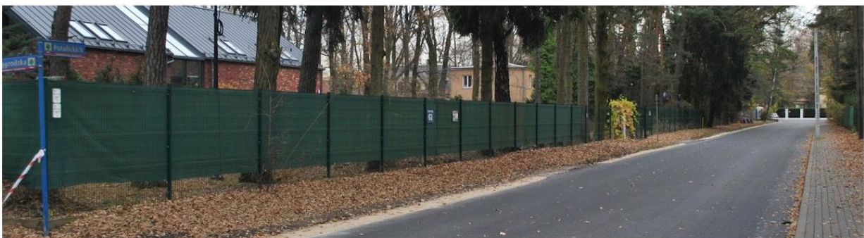
Nowy asfalt na ul. Potulickich
