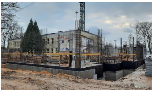
Przebudowa Szkoły Podstawowej w Słomczynie
