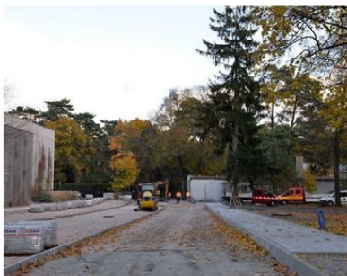
Budowa łącznika między ul. Wojewódzką, a ul. Rycerską
