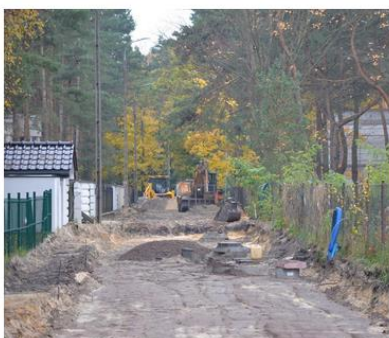
Budowa ul. Mostowej i Łącznej
