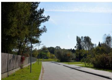
Przebudowa dróg w Czarnowie
