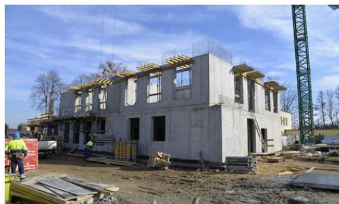
Przebudowa Szkoły Podstawowej w Słomczynie
