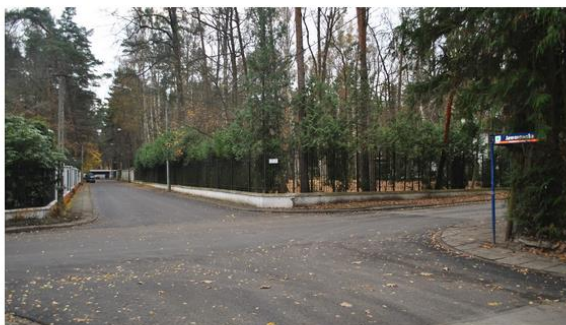
Przebudowa ulicy Jaworowskiej
