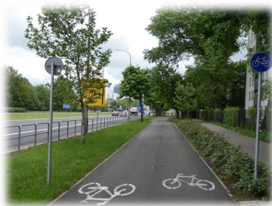
Foto. nr 2. Główna komunikacyjna trasa rowerowa. Dwukierunkowa droga dla rowerów, nawierzchnia asfaltowa [oznakowanie pionowe i poziome].
