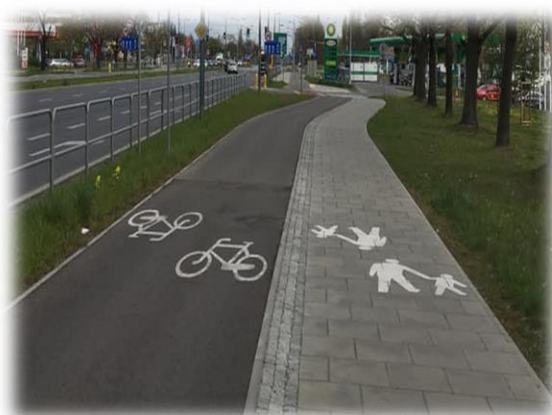
Foto. nr 3. Lokalna komunikacyjna trasa rowerowa. Dwukierunkowa droga dla rowerów, nawierzchnia asfaltowa separacja kostka granitową łupaną, droga dla pieszych, nawierzchnia płyty betonowe [oznakowanie pionowe i poziome].
