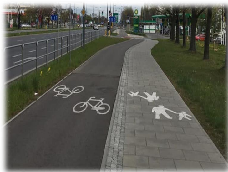
Foto nr 3. Lokalna komunikacyjna trasa rowerowa. Dwukierunkowa droga dla rowerów, nawierzchnia asfaltowa separacja kostka granitową łupaną, droga dla pieszych, nawierzchnia płyty chodnikowe betonowe.
