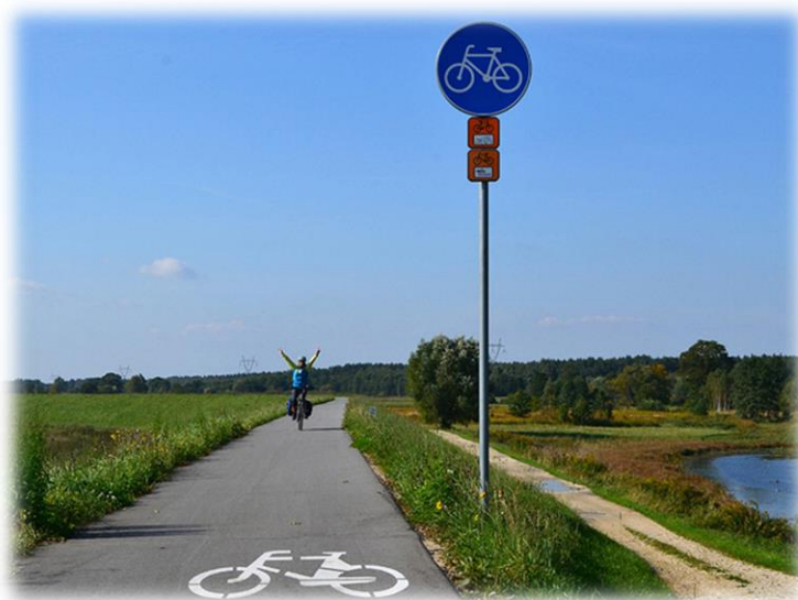
Foto nr 1. Wiślana Trasa Rowerowa (krajowa). Dwukierunkowa droga dla rowerów, nawierzchnia asfaltowa [oznakowanie pionowe i poziome].
