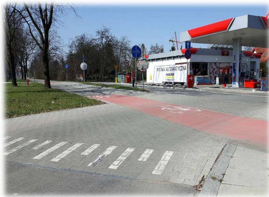
Foto nr 63. Przejazd dla rowerzystow w barwie czerwonej obok z przejsciem dla pieszych usytuowany na phtowym progu zwalnijacym.
