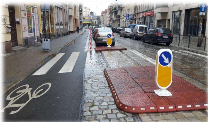
Foto nr 34. Koniec kontrapasa z zastosowaniem separacji.
