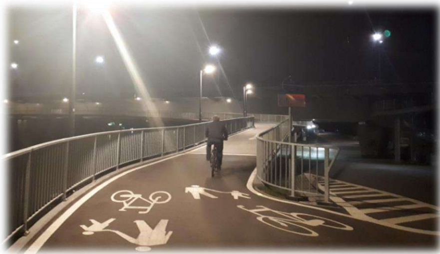
Foto nr 93. Oświetlenie kładki pieszo-rowerowej.
