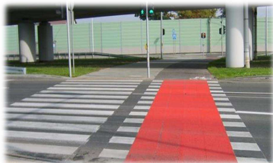
Foto nr 79. Zastosowanie sygnalizatora dwukolorowego dla pieszych S-5 i dwukolorowy sygnalizator dla rowerzystów S-6 umieszczony na jednym maszcie, po lewej stronie przejazdu dla rowerzystów. Stosuje się sygnał zielony dla pieszych i rowerzystów w tym samym czasie (pomimo technicznej możliwości oddzielnego sterowania tymi dwoma strumieniami).
