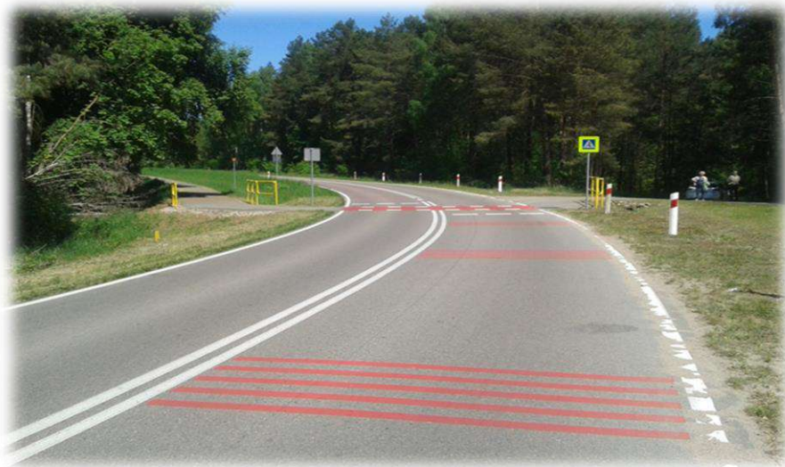
Foto nr 58. Odcinek dojazdowy do przejazdu dla rowerzystów na drodze poza obszarem zabudowanym z zastosowaniem hamowania optycznego (czerwone pasy poprzeczne).
