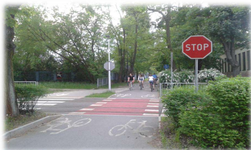
Foto nr 67. Przejazd dla rowerzystów (barwa czerwona) przez torowisko tramwajowe. Przy drodze dla rowerów zamieszczono znak B-20 „STOP”, ze względu na ograniczenie widoczności na przejeździe.
