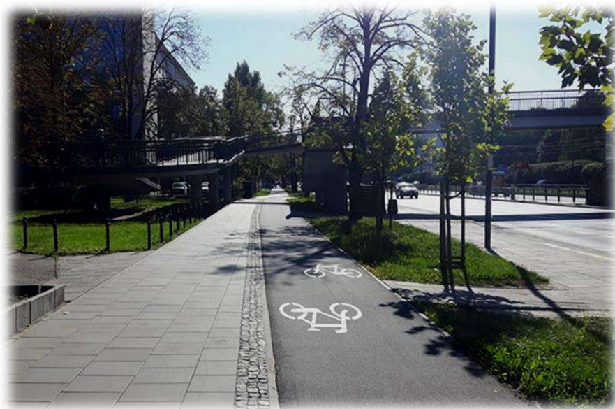
Foto nr 14. Separacja ruchu rowerowego od pieszego z kostki granitowej.
