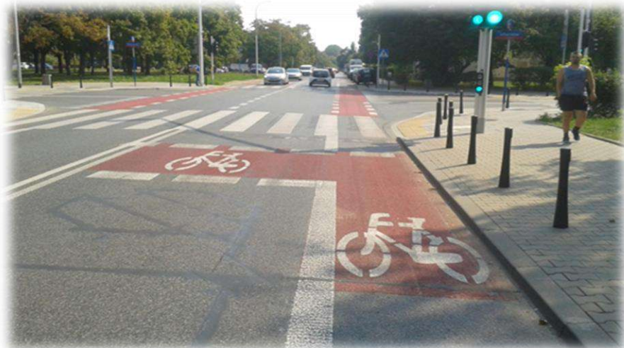
Foto nr 30. Śluza dla rowerów na jednopasowym wlocie na skrzyżowanie. Na śluzę naprowadza prasy ruchu dla rowerów umieszczony przy prawej krawędzi jezdni. W śluzie umieszczono znak poziomy P-23 „rower”.
