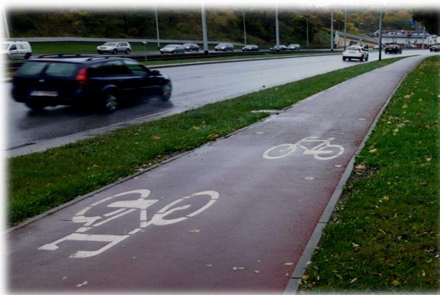
Foto nr 7. Wydzielona droga dla rowerów – dwukierunkowa (szerokość 2,0 m, oznakowanie poziome P-23).
