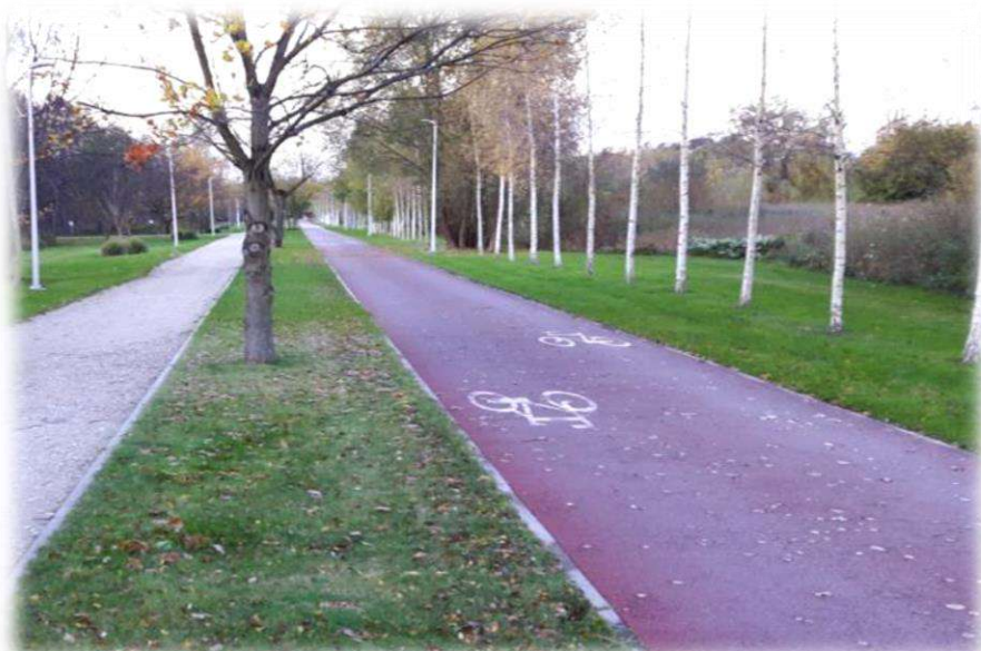
Foto nr 13. Zastosowanie separacji zieleni niskiej (trawnika) oraz drzew. Dodatkowym elementem jest zastosowanie nawierzchni dla rowerów w kolorze czerwonym. Trasa rowerowa o funkcji rekreacyjnej w parku miejskim.
