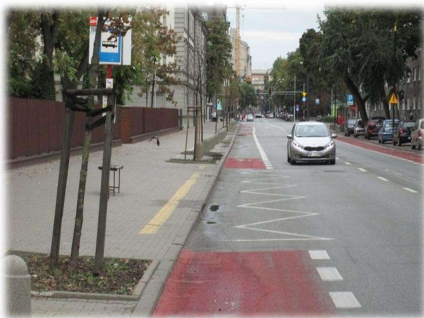
Foto nr 52. Pas ruchu dla rowerów przy krawężniku z przerwą na przystanek autobusowy.
