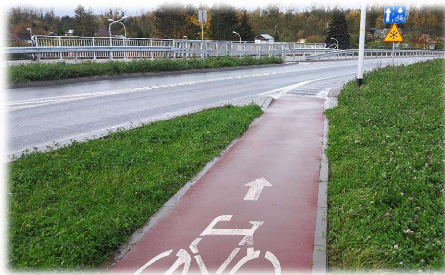
Foto nr 44. Zjazd z jednokierunkowej drogi dla rowerów (w barwie czerwonej) na jednokierunkowy pas ruchu dla rowerów.
