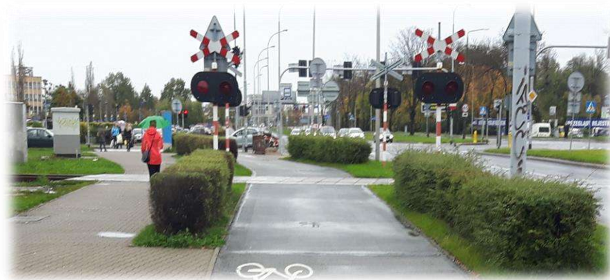
Foto nr 64. Droga dla rowerów i przejazd dla rowerzystów na przejeździe kolejowym bez zapór z sygnalizacją ostrzegawczą.
