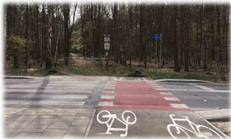
Foto nr 59. Przejazd dla rowerzystów i przejście dla pieszych poza obszarem zabudowanym.
