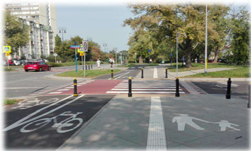
Foto nr 62. Przejazd dla rowerzystów połączony z przejściem dla pieszych usytuowany na płytowym progu zwalniającym.
