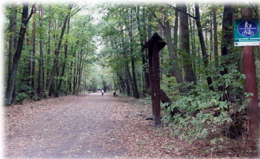
Foto nr 55. Szlak pieszo-rowerowy w lesie miejskim (szerokość 5 m), nawierzchnia gruntowa. Wspólny szlak pieszo-rowerowy można realizować, ale w przypadku zastosowania odpowiednich parametrów szerokości (min. 4 szerokości, zaleca się 5 m szerokości).
