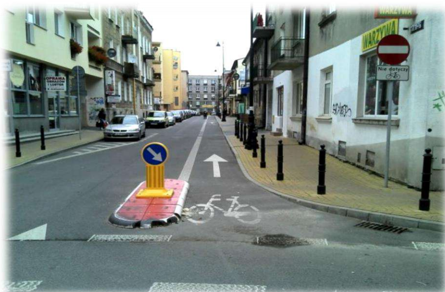
Foto nr 24. Kontrapas, oddzielony od pozostałej części jezdni linią ciągłą, z oznakowaniem pionowym i poziomym i zastosowaniem słupka przeszkodowego U-5b.
