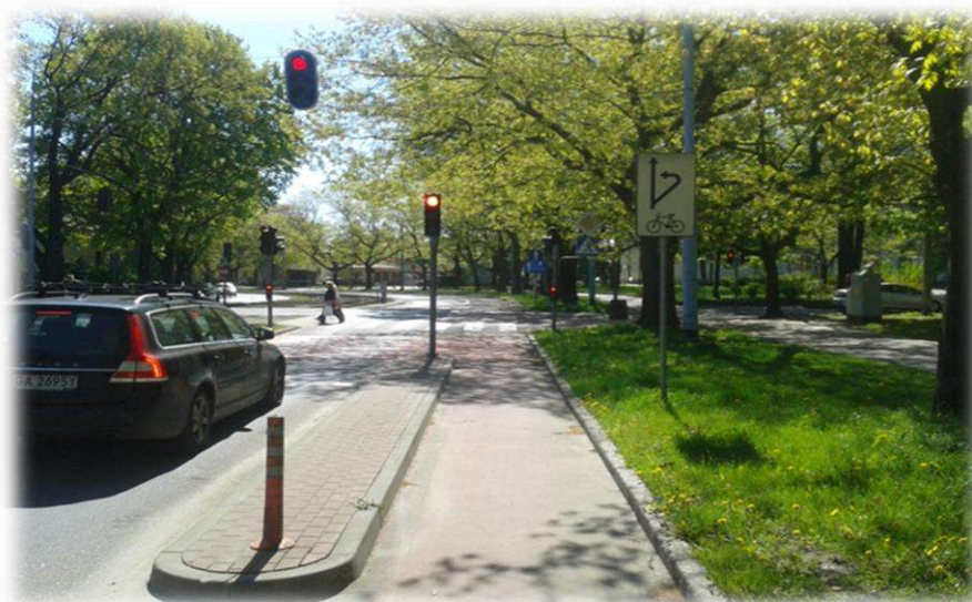
Foto nr 38. Pas ruchu dla rowerów naprowadzający na służę (azyl dla rowerzystów), który umożliwia skręt w lewo (z sygnalizacją świetlną) i separacją ruchu. Tęgo typu rozwiązanie zapewnia zdecydowanie większe bezpieczeństwo rowerzystom.
