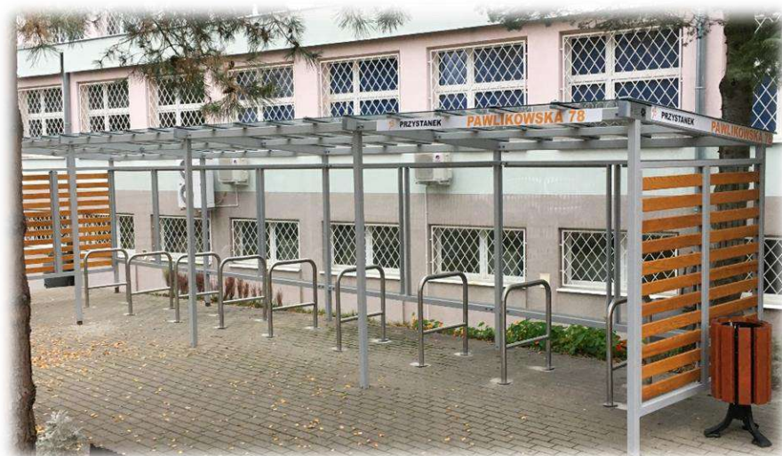
Foto nr 82. Zadaszona wiata z parkingiem dla rowerów na terenie szkoły w Warszawie.
