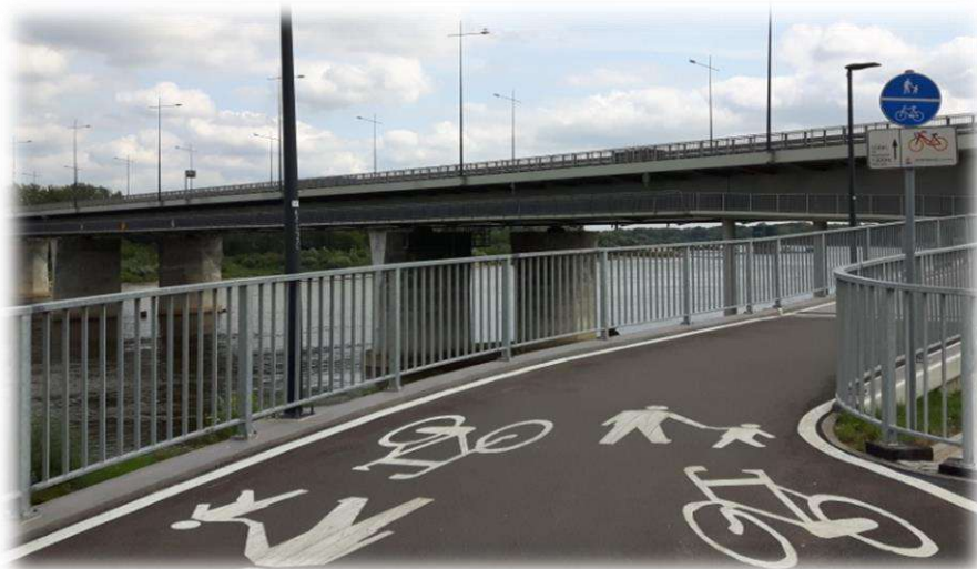
Foto nr 92. Kładka pieszo-rowerowa (Most Łazienkowski) z czytelnym oznakowaniem pionowym i poziomym.
