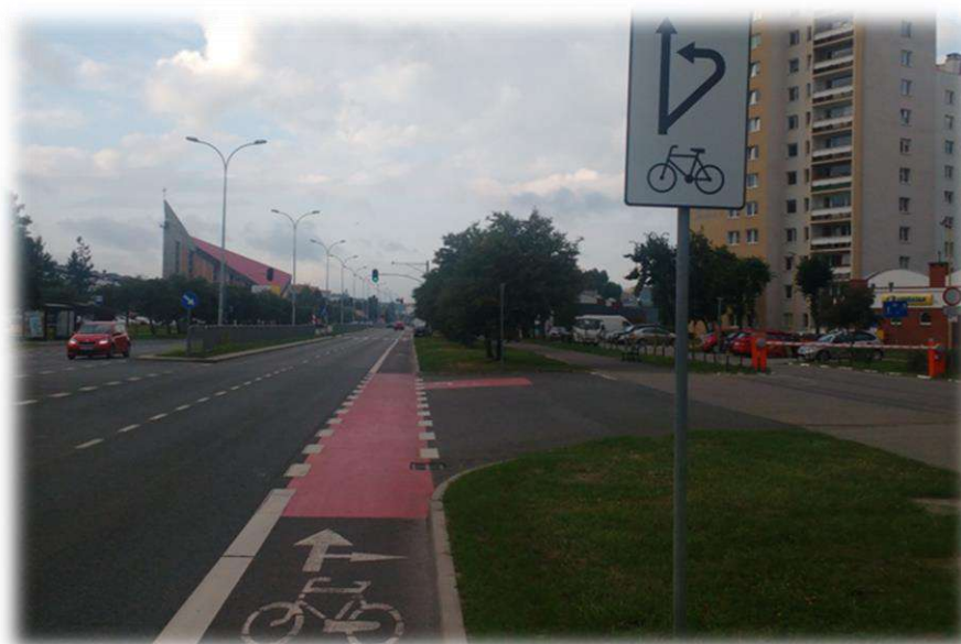
Foto nr 28. Pasy ruchu dla rowerów. Dojazd do skrzyżowania na którym zastosowano znak poziomy P-27 „kierunek i tor ruchu rowerów”.
