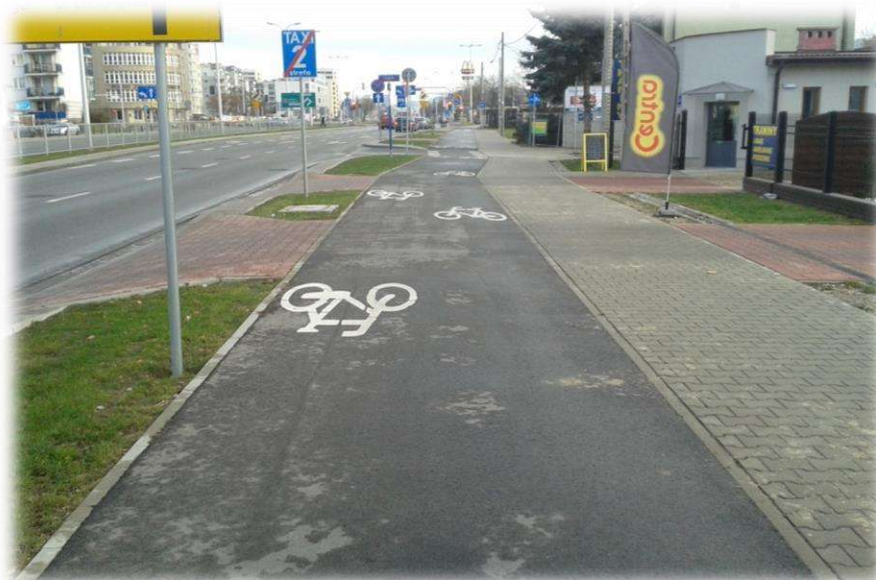
Foto nr 8. Przykład prawidłowo zaprojektowanej drogi dla rowerów przy wjeździe do posesji. Droga dla rowerów powinna być równa, także przy wjazdach do posesji.
