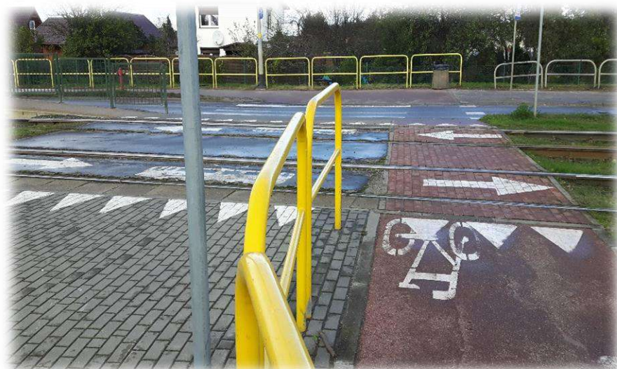
Foto nr 68. Przejazd dla rowerzystów przez torowisko tramwajowe z barierkami oddzielającymi ruch rowerowy od pieszego.
