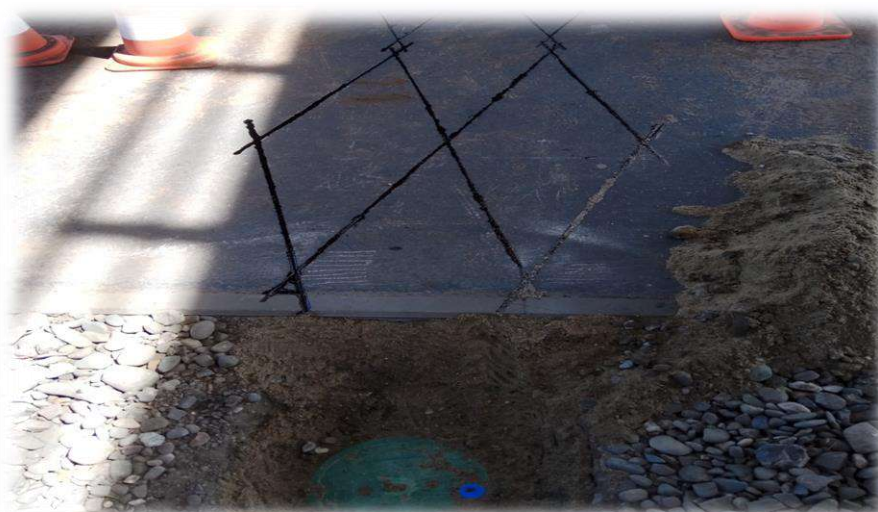
Foto nr 96. Montaż pętli indukcyjnej w drodze dla rowerów (nawierzchnia asfaltowa).
