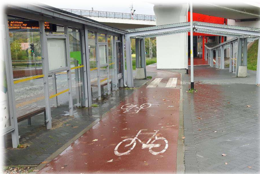
Foto nr 50. Droga dla rowerów przy przystanku komunikacji autobusowej.
