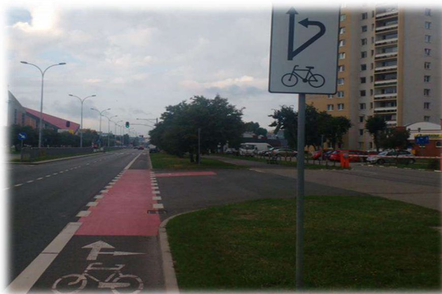
Foto nr 37. Pas ruchu dla rowerów naprowadzający na służę (azyl dla rowerzystów), który umożliwia skręt w lewo (bez sygnalizacji świetlnej).
