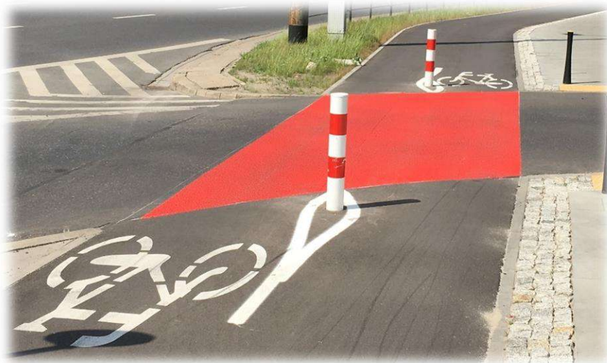
Foto nr 104. Przykład zastosowania słupków blokujących U 12c na drodze dla rowerów w miejscu, gdzie istnieje ryzyko parkowania samochodów na infrastrukturze dedykowanej rowerzystom.
