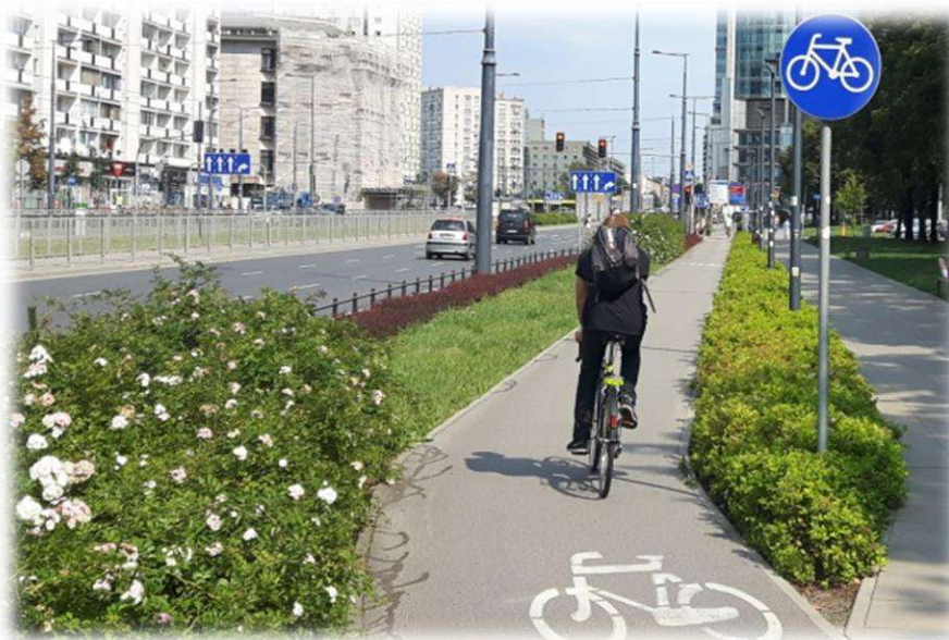
Foto nr 4. Wydzielona droga dla rowerów – jednokierunkowa (szerokość 1,5 m, nawierzchnia asfaltowa, oznakowanie pionowe C-13, oznakowanie poziome P-23).
