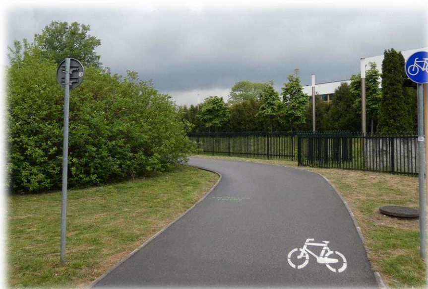
Foto nr 16. Początek drogi dla rowerów (znak C-13).
