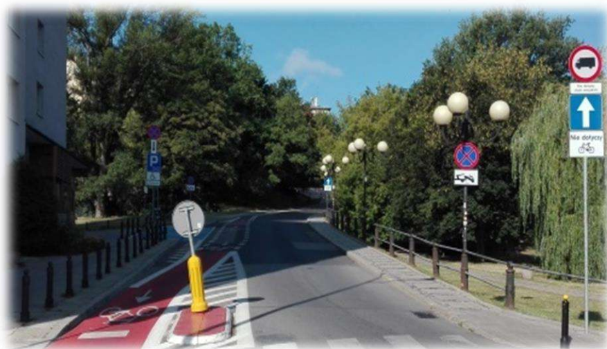
Foto nr 32. Koniec kontrapasa, wlot na skrzyżowanie (znaki pionowe: D-3 „droga jednokierunkowa”, tabliczka T-22 „nie dotyczy rowerów” umieszczona pod znakami).
