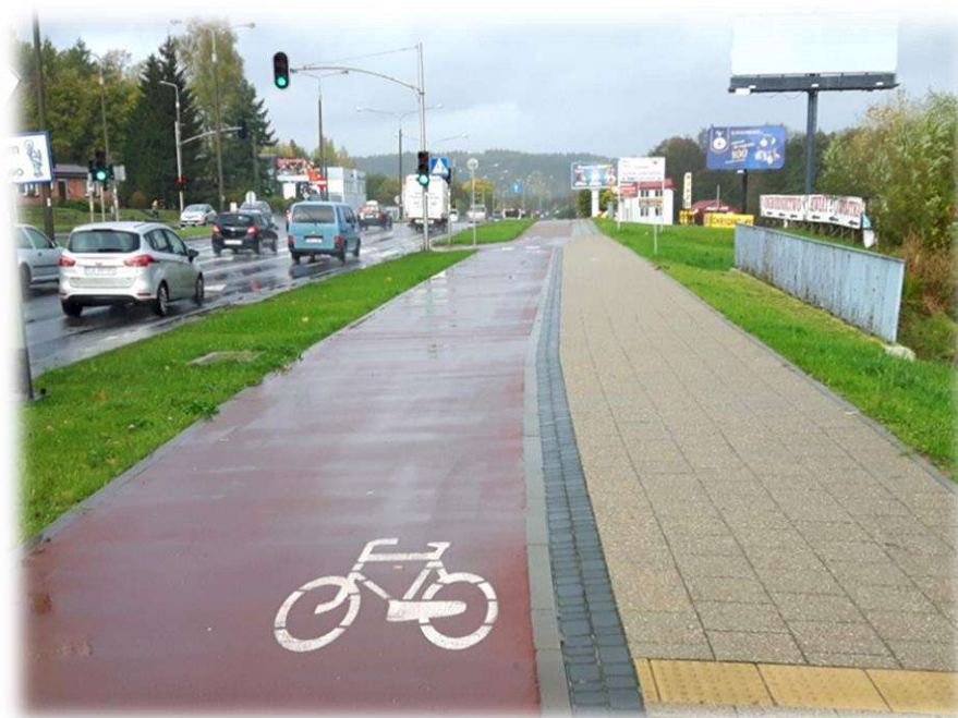
Foto nr 15 Separacja ruchu rowerowego od pieszego kostką betonową.
