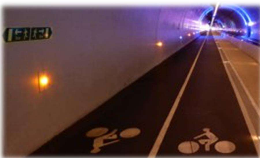
Foto nr 101. Tunel rowerowy we Francji w mieście Lyon. Źródło: http://rowerowytorun.com.pl/ .
