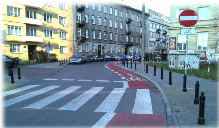
Foto nr 33. Początek kontrapasa. (znaki pionowe: D-3 „droga jednokierunkowa”, B-2 „zakaz wjazdu”, tabliczka T-22 „nie dotyczy rowerów” umieszczona pod znakami).
