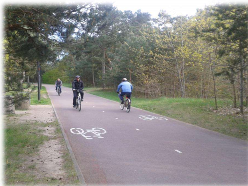
Foto nr 104. Rowerostrada (dwukierunkowa droga dla rowerów; 4 m szerokości, nawierzchnia asfaltowa), prowadzi wzdłuż Zatoki Gdańskiej (m. Jelitkowo).
