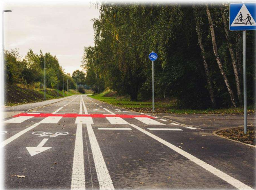
Foto nr 106. Rowerostrada (dwukierunkowa droga dla rowerów; 2x3 m szerokości, nawierzchnia asfaltowa) w mieście Jaworzno. Źródło: Urząd Miejski w Jaworznie.
