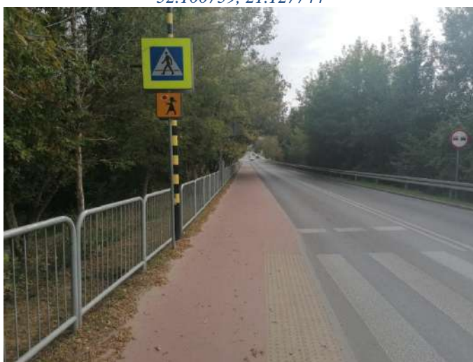
Foto nr 20 [w kierunku wschodnim] ul. Mirkowska [droga dla rowerów i pieszych, nawierzchnia z kostki betonowej niefazowanej – szer. 2,3 m] 52.100740, 21.127816
