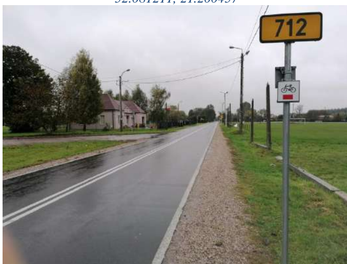
Foto nr 246 [w kierunku północno-zachodnim] DW 712 m. Gassy [nawierzchnia asfaltowa] 52.079788, 21.202514
