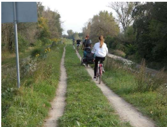
Foto nr 229 [w kierunku południowym] na wale przeciwpowodziowym rzeki Wisła 52.14340, 21.154668
