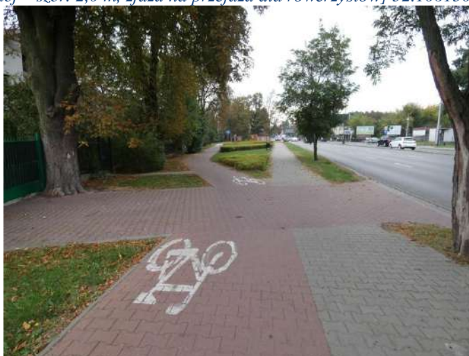
Foto nr 10 [w kierunku południowym] ul. Warszawska [droga dla pieszych i droga dla rowerów przechodzi w drogę dla rowerów, nawierzchnia z kostki betonowej niefazowanej – szer. 2,0 m] 52.104575, 21.114095
