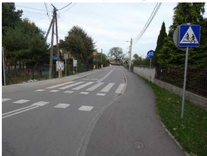
Foto nr 82 [w kierunku wschodnim] ul. Wspólna [droga dla rowerów, nawierzchnia asfaltowa – szer. 1,5 m] 52.108544, 21.130170
