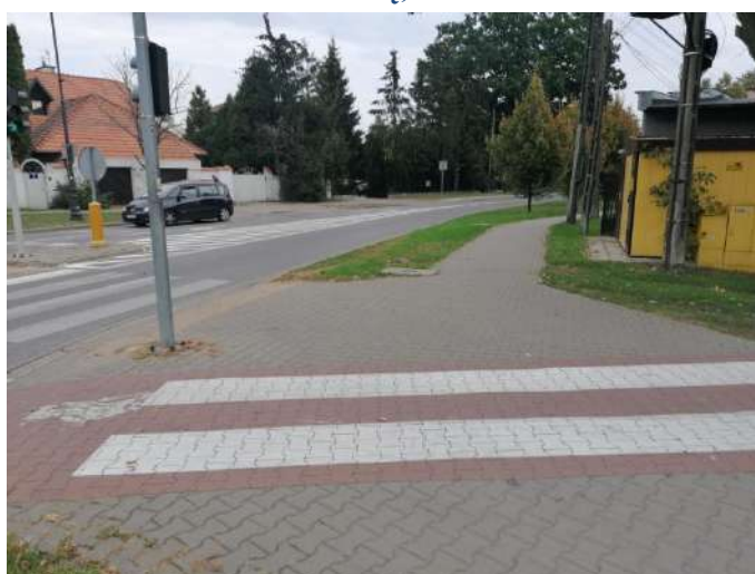
Foto nr 13 [w kierunku wschodnim] ul. Mirkowska [chodnik, nawierzchnia z kostki betonowej fazowanej – szer. 2,0 m] 52.102732, 21.114596
