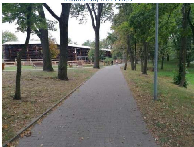
Foto nr 37 [w kierunku zachodnim] Park Zdrojowy Aleja Pisogne na wysokości Tężni Solankowej [droga dla rowerów i pieszych, nawierzchnia z kostki betonowej niefazowanej – szer. 3,1 m] 52.086341, 21.113790
