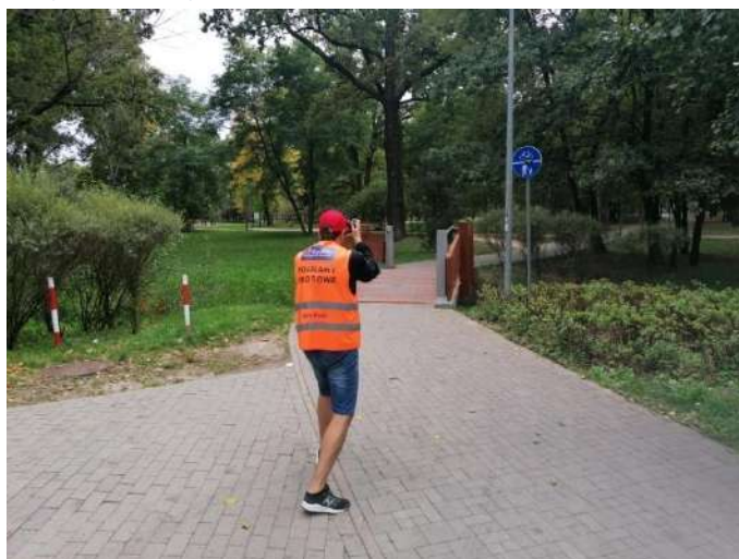
Foto nr 34 [w kierunku zachodnim] od ul. Matejki w kierunku Tężni Solankowej [droga dla rowerów i pieszych, nawierzchnia z kostki betonowej niefazowanej – szer. 3.1 m] 52.086596, 21.118310
