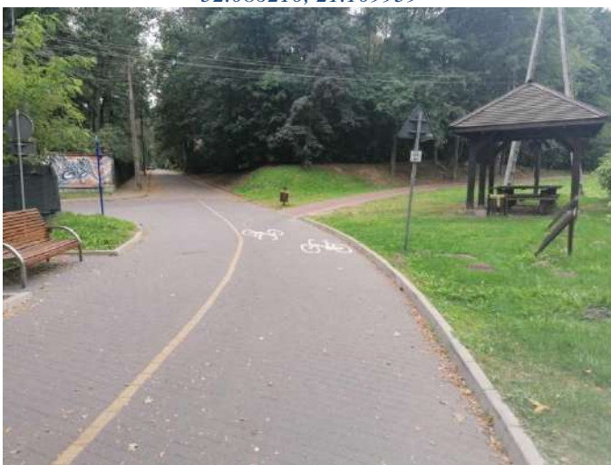
Foto nr 45 [w kierunku południowym] Park Zdrojowy ul. Mostowa – Bulwar skrzyżowanie z ul. Szpitalną [droga dla pieszych i droga dla rowerów, nawierzchnia z kostki betonowej niefazowanej – szer.2,2 m i 2,5 m] 52.082968, 21.104602
