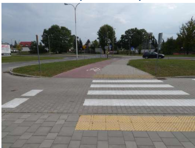
Foto nr 26 [w kierunku południowo-wschodnim] ul. Torowa w kierunku ul. Piaseczyńskiej [droga dla pieszych i droga dla rowerów, nawierzchnia z kostki betonowej fazowanej szer. – 2,0 m i niefazowanej – szer. 2,5 m] 52.091212, 21.111475
