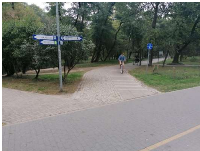
Foto nr 40 [w kierunku północnym] Park Zdrojowy ul. Sienkiewicza na wysokości Tężni Solankowej [droga dla pieszych i droga dla rowerów, nawierzchnia z kostki betonowej niefazowana oraz płyt granitowych – szer. 2,5 m i 2,5 m, niewłaściwe oznakowanie drogi dla pieszych i drogi dla rowerów] 52.086040, 21.111809
