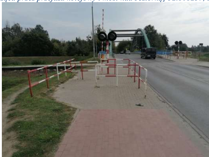
Foto nr 18b [w kierunku wschodnim] ul. Mirkowska, przejazd przez tory kolejowe [droga dla rowerów i pieszych, nawierzchnia z kostki betonowej niefazowanej – szer. 2,3 m, przechodząca przez przejazd kolejowy i most nad Jeziorką] 52.101237, 21.126507
