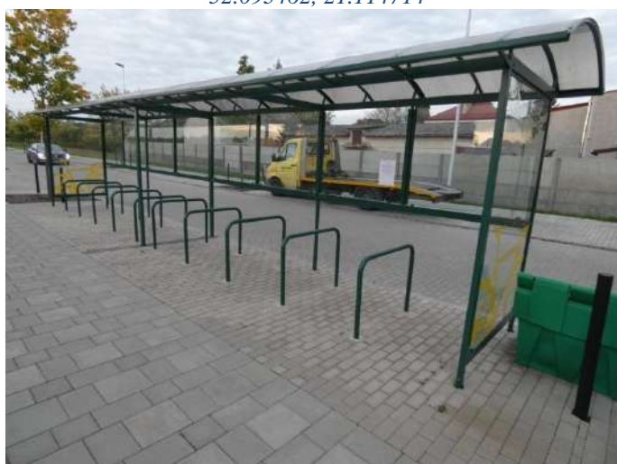
Foto nr 206 [w kierunku północnym] ul. Kolejowa 31 [Parking dla rowerów – 10 stanowisk] 52.093462, 21.114714
