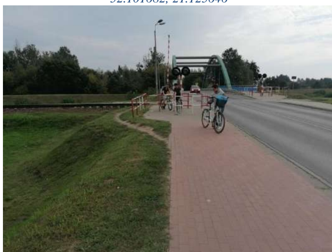
Foto nr 18a [w kierunku wschodnim] ul. Mirkowska [droga dla rowerów i pieszych, nawierzchnia z kostki betonowej niefazowanej – szer. 2,3 m, przechodząca przez przejazd kolejowy i most nad Jeziorką] 52.101237, 21.126507
