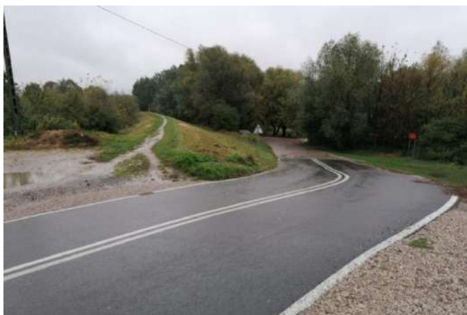
Foto nr 247a [w kierunku północnym] DW 712 m. Gassy [nawierzchnia asfaltowa] 52.078147, 21.206347
