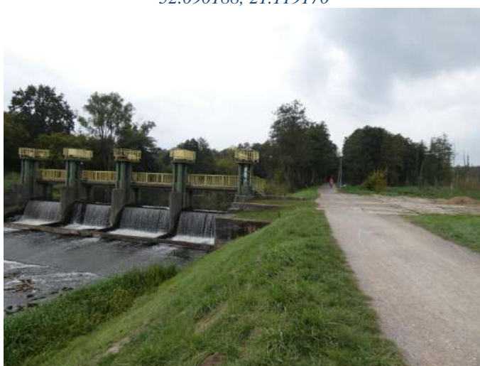
Foto nr 54 [w kierunku południowym] widok na Jaz Imberfal wzdłuż Jeziorki w kierunku Parku Zdrojowego [droga dla rowerów i pieszych, nawierzchnia gruntowa – szer. 3,5 m] 52.090643, 21.119453
