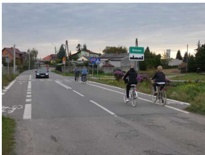
Foto nr 89 [w kierunku południowym] ul. Okrzewska [pasy ruchu dla rowerów, nawierzchnia asfaltowa – szer. 1,5 m] 52.110745, 21.132052
