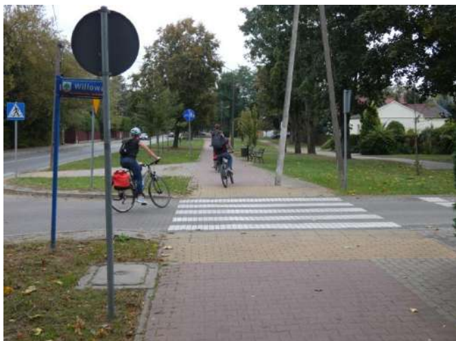
Foto nr 14 [w kierunku wschodnim] ul. Mirkowska skrzyżowanie z ul. Willową [droga dla rowerów i pieszych, nawierzchnia z kostki betonowej niefazowanej – szer. 2,3 m] 52.102460, 21.117009
