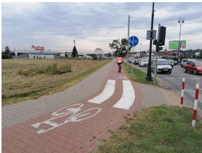
Foto nr 8 [w kierunku południowym] ul. Warszawska [droga dla pieszych i droga dla rowerów, nawierzchnia z kostki betonowej fazowanej szer. – 1,5 m i niefazowanej – szer. 2,0 m] 52.109673, 21.113215
