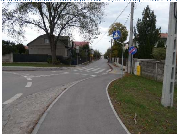
Foto nr 83 [w kierunku wschodnim] ul. Wspólna [droga dla rowerów, nawierzchnia asfaltowa – szer. 1,5 m] 52.108829, 21.131416
