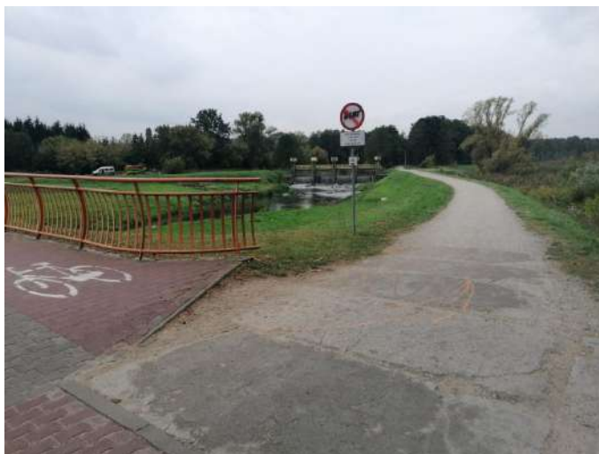
Foto nr 55 [w kierunku południowym] ul. Warszawska wzdłuż Jeziorki w kierunku Parku Zdrojowego [droga dla rowerów i pieszych, nawierzchnia z płyt betonowych – szer. 2,5 m] 52.091382, 21.120014
