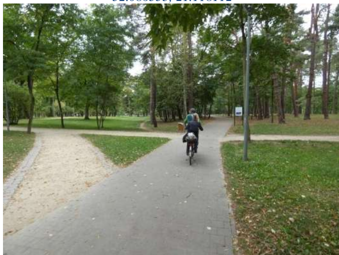
Foto nr 36 [w kierunku północnym] Park Zdrojowy Aleja Pisogne [droga dla rowerów i pieszych, nawierzchnia z kostki betonowej niefazowanej – szer. 3,1 m] 52.086414, 21.117762
