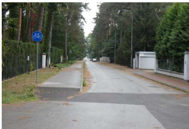
Foto nr 61 [w kierunku północnym] ul. Piaskowa skrzyżowanie z ul. Przesmyckiego [droga dla rowerów, nawierzchnia asfaltowa – szer. 2,0 m] 52.073445, 21.075448
