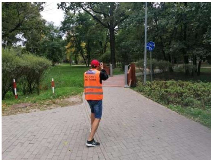
Foto nr 34 [w kierunku zachodnim] Park Zdrojowy od ul. Matejki w kierunku Tężni Solankowej [droga dla rowerów i pieszych, nawierzchnia z kostki betonowej niefazowanej – szer. 3,1 m] 52.086596, 21.118310
