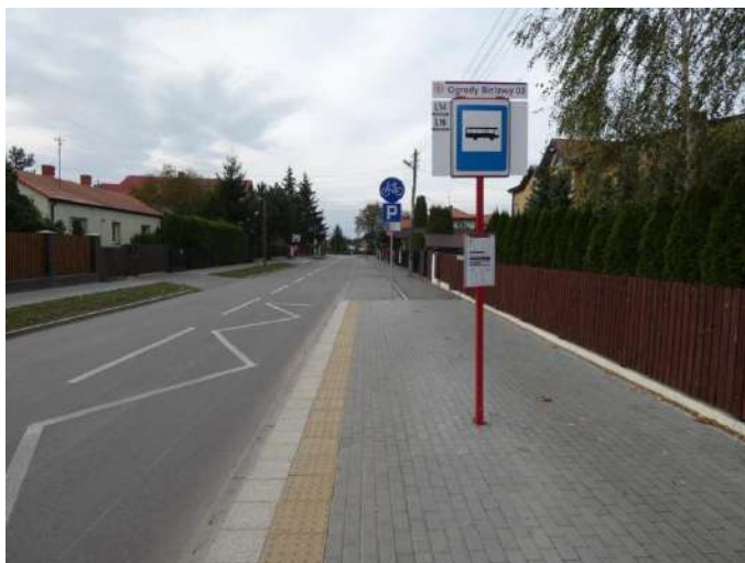
Foto nr 79 [w kierunku wschodnim] ul. Powsińska [droga dla rowerów i pieszych, nawierzchnia z kostki betonowej niefazowanej – szer. 3,0 m] 52.107762, 21.130531
