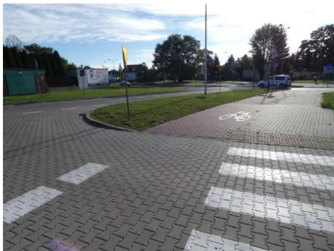
Foto nr 104 [w kierunku południowo-wschodnim] ul. Torowa w kierunku ul. Piaseczyńskiej [droga dla pieszych i droga dla rowerów, nawierzchnia z kostki betonowej fazowanej szer. – 2,0 m i niefazowanej – szer. 2,5 m] 52.091199, 21.111504
