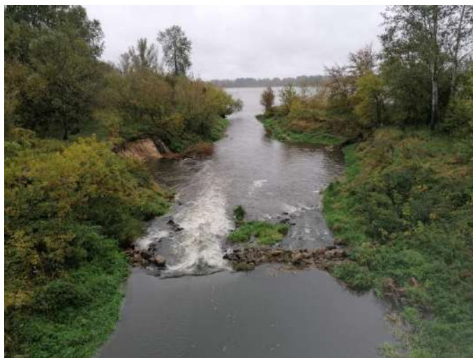
Foto nr 239 [w kierunku północno-wschodnim] widok z mostu ujście Jeziorki do Wisły w m. Obórki 52.120859, 21.174660
