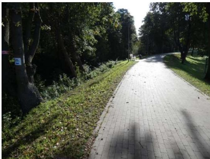
Foto nr 113 [w kierunku południowo-wschodnim] od ul. Elektrycznej do Parku Zdrojowego [droga dla rowerów i pieszych, nawierzchnia z kostki betonowej niefazowanej – szer. 3,0 m] 52.088351, 21.109707
