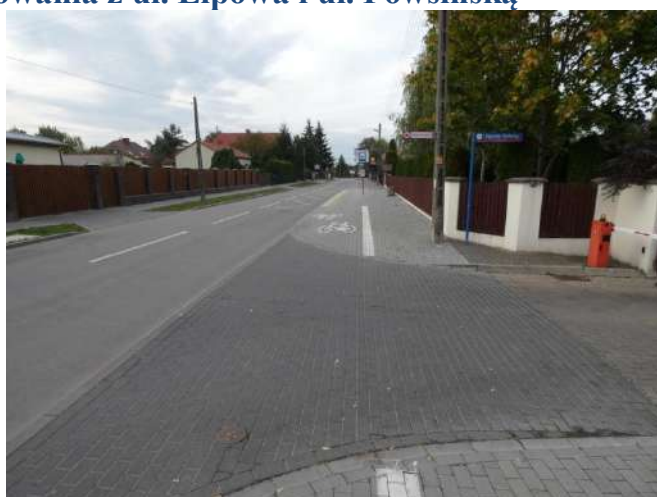
Foto nr 77 [w kierunku północnym] ul. Powsińska skrzyżowanie z ul. Ogrody Bielawy [droga dla rowerów i pieszych, nawierzchnia z kostki betonowej niefazowanej – szer. 3,5 m] 52.107348, 21.130774
