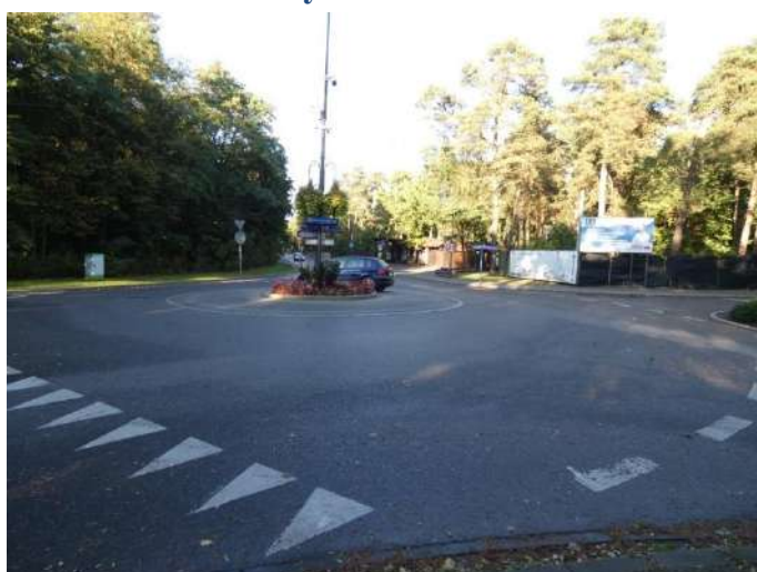
Foto nr 66 [w kierunku południowym] rondo im. Danuty Siedzikówny w kierunku ul. Wareckiej [ruch rowerowy na zasadach ogólnych, nawierzchnia asfaltowa] 52.077560, 21.117425
