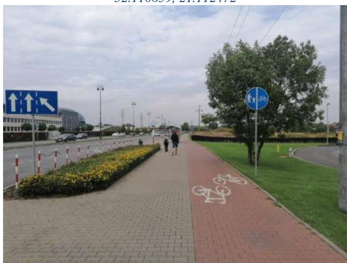
Foto nr 6 [w kierunku północnym] ul. Warszawska [droga dla pieszych i droga dla rowerów, nawierzchnia z kostki betonowej fazowanej szer. – 2,5 m i niefazowanej – szer. 2,0 m] 52.110236, 21.112912
