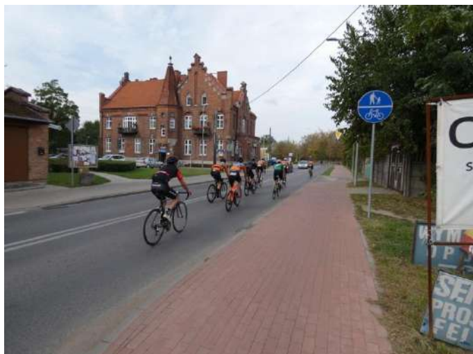
Foto nr 22 [w kierunku północnym] ul. Mirkowska [droga dla rowerów i pieszych, nawierzchnia z kostki betonowej niefazowanej – szer. 2,3 m] 52.097011, 21.135890
