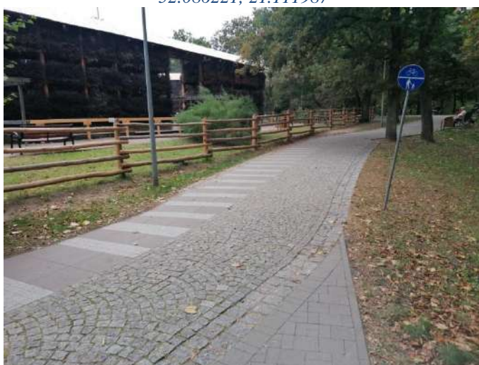
Foto nr 39 [w kierunku zachodnim] Park Zdrojowy na wysokości Tężni Solankowej [droga dla pieszych i droga dla rowerów, nawierzchnia z kostki granitowej – szer. 1,5 m i z płyt granitowych – szer. 1,5 m, nieprawidłowe oznakowanie] 52.086360, 21.113232
