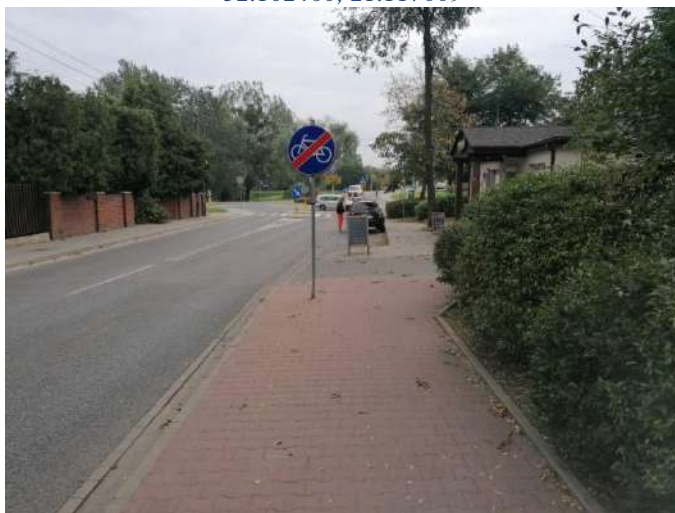
Foto nr 15 [w kierunku wschodnim] ul. Mirkowska [droga dla rowerów i pieszych, nawierzchnia z kostki betonowej niefazowanej – szer. 2,3 m] 52.101624, 21.124549
