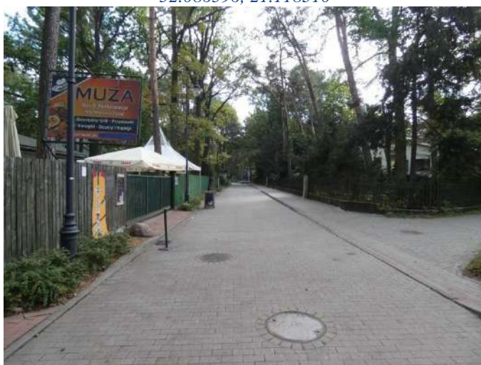
Foto nr 115 [w kierunku południowo-wschodnim] ul. Matejki [droga dla rowerów i pieszych, nawierzchnia z kostki betonowej niefazowanej – szer. 5,0 m] 52.086030, 21.119232
