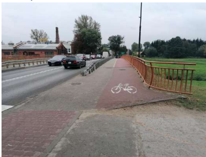
Foto nr 57 [w kierunku południowo-wschodnim] ul. Warszawska most nad Jeziorką [droga dla pieszych i droga dla rowerów, nawierzchnia z kostki betonowej fazowanej szer. 2,0 m i niefazowana szer. 2,5 m na moście nawierzchnia betonowo-żywiczna] 52.091382, 21.120014
