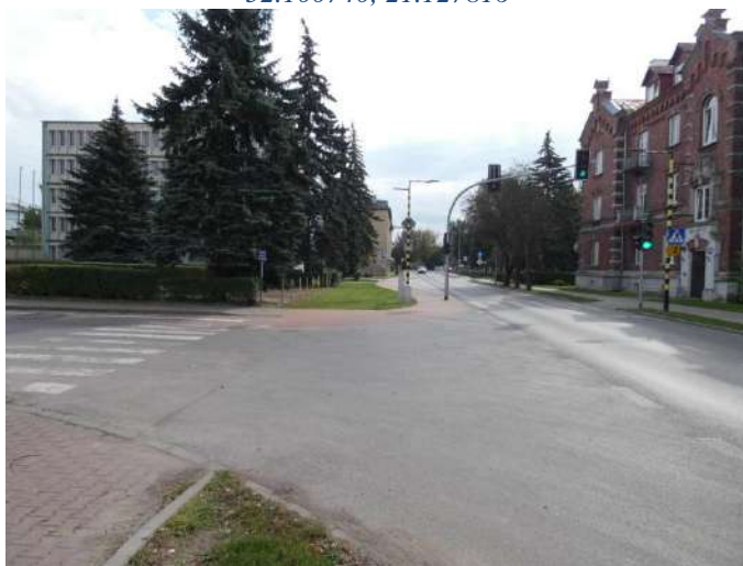
Foto nr 21 [w kierunku południowym] ul. Mirkowska [droga dla rowerów i pieszych, nawierzchnia z kostki betonowej niefazowanej – szer. 2,3 m, brak przejazdu dla rowerzystów przez jezdnię] 52.096961, 21.135784
