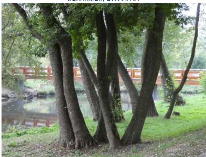
Foto nr 51 [w kierunku południowo-zachodnim] Park Zdrojowy wzdłuż Jeziorki widok na most Parkowy na Jeziorce [droga dla rowerów i pieszych, nawierzchnia z kostki betonowej niefazowanej – szer. 3,0 m] 52.086542 21.111356
