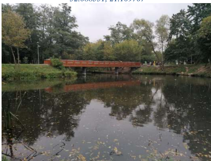
Foto nr 50 [w kierunku wschodnim] Park Zdrojowy widok na most Parkowy na Jeziorce [droga dla rowerów i pieszych, nawierzchnia drewniana – szer. 2,0 m] 52.086339, 21.110842
