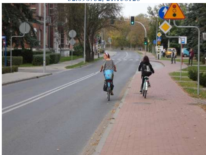
Foto nr 24 [w kierunku północnym] ul. Mirkowska [droga dla rowerów i pieszych, nawierzchnia z kostki betonowej niefazowanej – szer. 2,3 m] 52.096413, 21.136329
