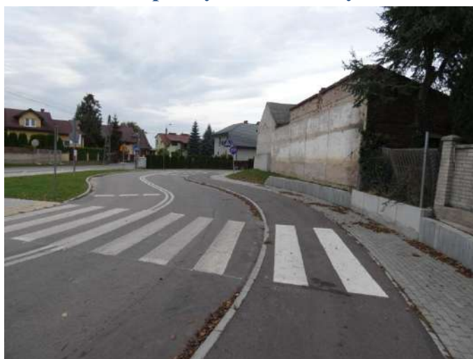
Foto nr 84 [w kierunku północnym] ul. Bociania [droga dla rowerów, nawierzchnia asfaltowa – szer. 1,5 m] 52.108921, 21.131593
