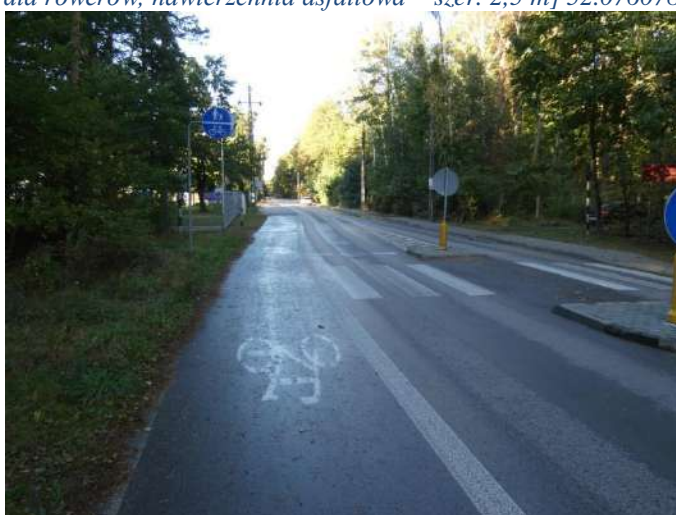
Foto nr 68 [w kierunku północnym] ul. Warecka [pas ruchu dla rowerów, nawierzchnia asfaltowa – szer. 2,5 m] 52.075698, 21.117355
