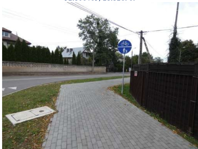
Foto nr 75 [w kierunku północnym] ul. Lipowa skrzyżowanie z ul. Bielawską [droga dla rowerów i pieszych, nawierzchnia z kostki betonowej niefazowanej – szer. 3,0 m] 52.106371, 21.128872
