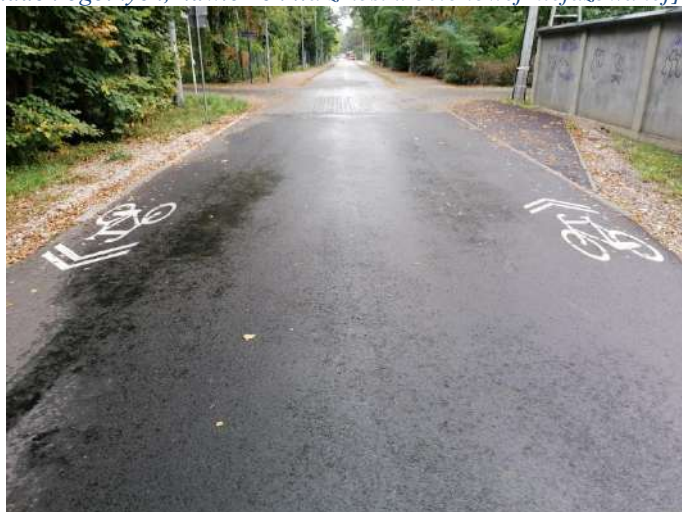
Foto nr 65 [w kierunku południowym] ul. Grechuty (gmina Piaseczno) w kierunku ul. Przesmyckiego [ruch rowerów na zasadach ogólnych, nawierzchnia asfaltowa, zastosowanie znaku poziomego P-27 „kierunek i tor ruchu roweru” – szer. 5,0 m] 52.080259, 21.075181
