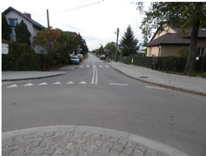
Foto nr 81 [w kierunku południowym] ul. Powsińska [droga dla rowerów i pieszych, nawierzchnia z kostki betonowej niefazowanej – szer. 3,0 m] 52.108529, 21.130047
