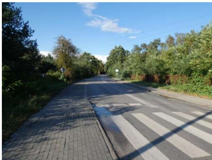
Foto nr 70 [w kierunku północnym] ul. Warecka [droga dla rowerów i pieszych – nawierzchnia z kostki betonowej, przechodzi w pas ruchu dla rowerów, nawierzchnia asfaltowa – szer. 2,5 m] 52.052897, 21.111836
