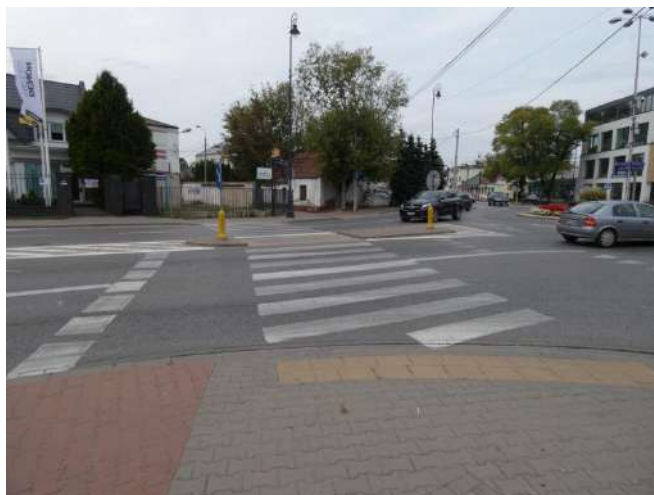
Foto nr 31 [w kierunku północnym] ul. Piaseczyńskiej skrzyżowanie z ul. Warszawską [koniec drogi dla pieszych i drogi dla rowerów, nawierzchnia z kostki betonowej fazowanej szer. – 2,0 m i niefazowanej – szer. 2,5 m] 52.093737, 21.117508
