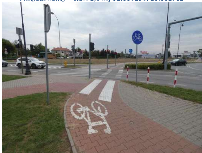
Foto nr 7 [w kierunku południowym] ul. Warszawska [zjazd z drogi dla rowerów o nawierzchni z kostki betonowej fazowanej na przejazd dla rowerzystów, nawierzchnia asfaltowa – szer. 2,0 m] 52.110159, 21.113107
