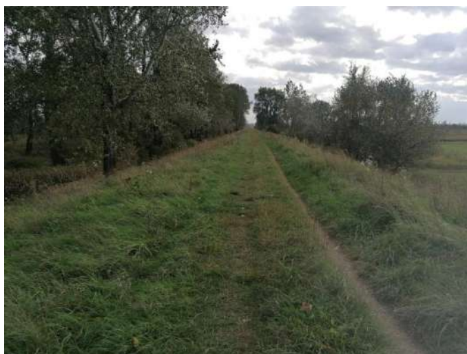
Foto nr 232 [w kierunku południowo-wschodnim] na wale przeciwpowodziowym rzeki Wisła 52.047821, 21.205375
