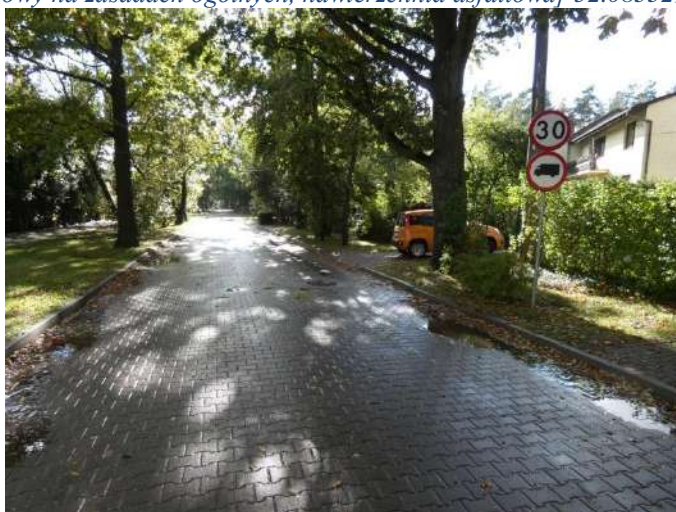
Foto nr 164 [w kierunku południowo-zachodnim] ul. Do Lasu [ruch rowerowy na zasadach ogólnych, nawierzchnia kostka betonowa faszynowa] 52.078917, 21.132341
