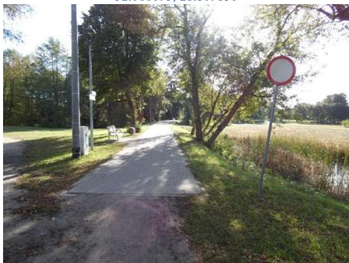
Foto nr 112 [w kierunku południowo-wschodnim] od ul. Elektrycznej do Parku Zdrojowego [droga dla rowerów i pieszych, nawierzchnia z kostki betonowej niefazowanej – szer. 3,0 m] 52.088803, 21.108775
