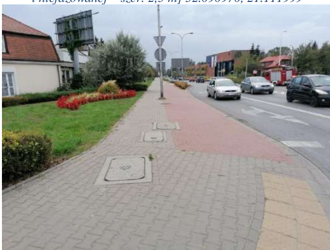
Foto nr 30 [w kierunku południowo-zachodnim] ul. Piaseczyńskiej na wysokości z ul. Warszawską [droga dla pieszych i droga dla rowerów, nawierzchnia z kostki betonowej fazowanej szer. – 2,0 m i niefazowanej – szer. 2,5 m] 52.093752, 21.117546
