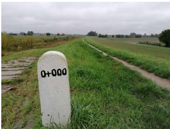
Foto nr 237 [w kierunku południowym] wał przeciwpowodziowy wzdłuż Jeziorki w okolicy mostu ujścia Jeziorki do Wisły [nawierzchnia gruntowa] 52.120863, 21.174042
