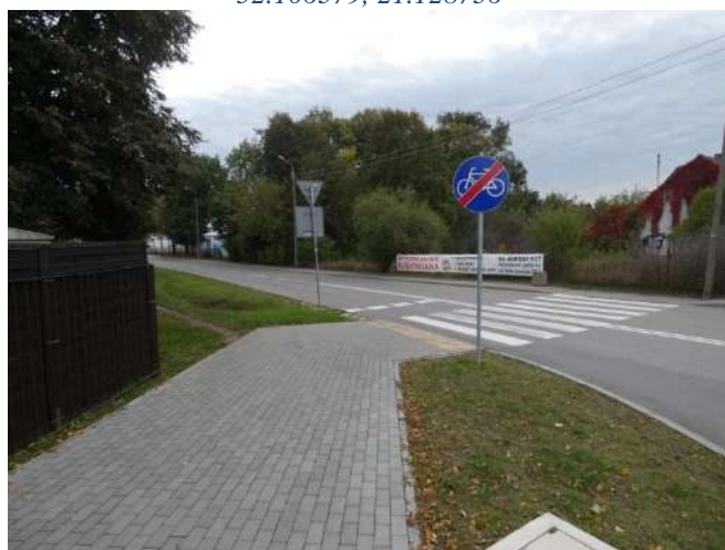
Foto nr 74 [w kierunku zachodnim] ul. Lipowa skrzyżowanie z ul. Bielawską [droga dla rowerów i pieszych, nawierzchnia z kostki betonowej niefazowanej – szer. 3,0 m] 52.106465, 21.128969
