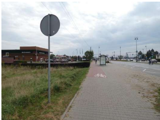
Foto nr 5 [w kierunku południowym] ul. Warszawska [droga dla rowerów i pieszych, nawierzchnia z kostki betonowej niefazowanej – szer. 3,0 - 4,5 m] 52.110659, 21.112472
