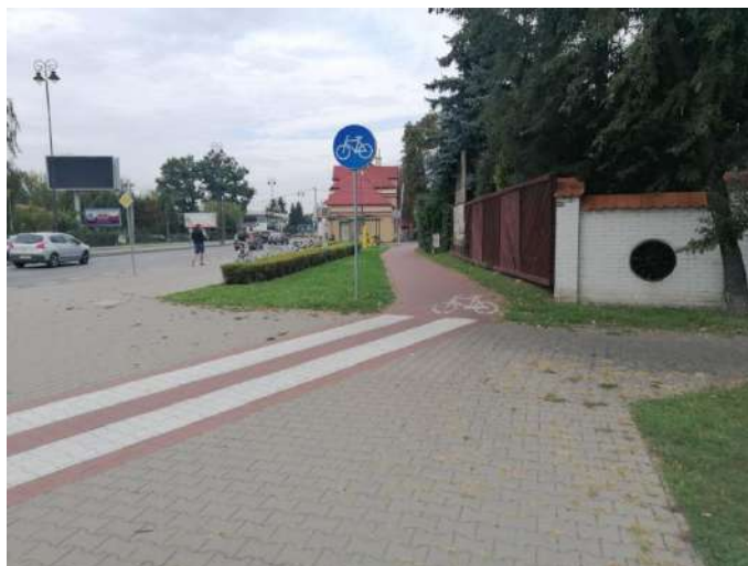
Foto nr 11 [w kierunku północnym] ul. Warszawska [droga dla rowerów, nawierzchnia z kostki betonowej niefazowanej – szer. 2,0 m] 52.102856, 21.114630
