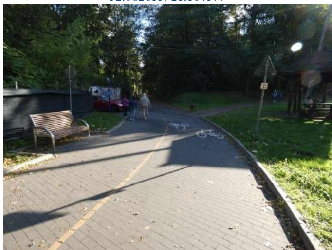
Foto nr 179 [w kierunku południowym] Bulwar im. prof. Jana Hafka skrzyżowanie z ul. Szpitalną [ruch rowerowy na zasadach ogólnych, nawierzchnia z kostki betonowej niefazowanej] 52.082894, 21.104582
