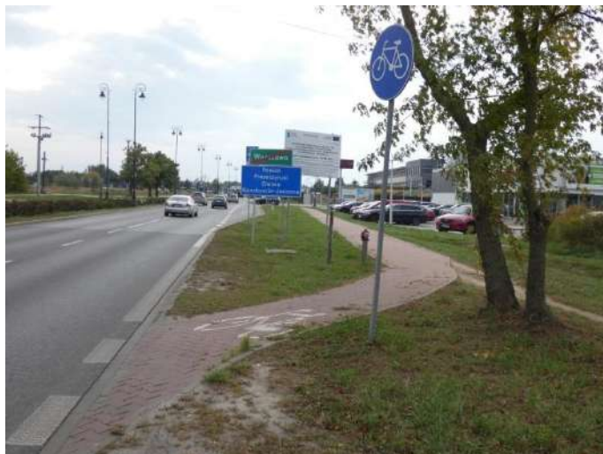
Foto nr 1 [w kierunku południowym] ul. Warszawska (granica z m. st. Warszawa) [wjazd z jezdni na drogę dla rowerów - nawierzchnia z kostki betonowej fazowanej – szer. 2,0 m] 52.113140, 21.109649
