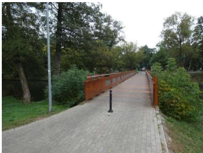
Foto nr 48 [w kierunku południowo-wschodnim] Park Zdrojowy widok na most Parkowy na Jeziorce [droga dla rowerów i pieszych, nawierzchnia z kostki betonowej niefazowanej – szer. 2,0 m] 52.086435, 21.111190
