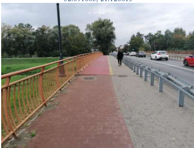
Foto nr 59 [w kierunku północno-zachodnim] ul. Warszawska most nad Jeziorką [droga dla pieszych i droga dla rowerów, nawierzchnia z kostki betonowej fazowanej szer. 2,0 m i niefazowana szer. 2,5 m na moście nawierzchnia betonowo-żywiczna] 52.090912, 21.120765
