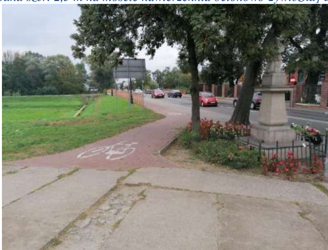
Foto nr 60 [w kierunku północno-zachodnim] ul. Warszawska w kierunku mostu nad Jeziorką [koniec drogi dla rowerów, nawierzchnia z kostki betonowej niefazowanej – szer. 2,0 m] 52.090618, 21.121192
