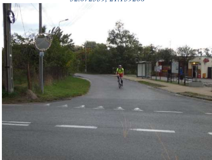
Foto nr 129 [w kierunku północnym] droga gminna z DW 868 w m. Cieciszew [ruch rowerowy na zasadach ogólnych, nawierzchnia asfaltowa] 52.060281, 21.175257
