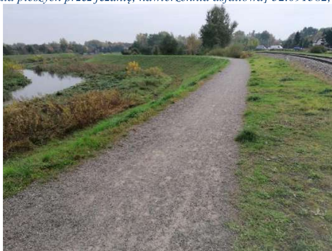
Foto nr 251 [w kierunku południowym] wał przeciwpowodziowy wzdłuż Jeziorki w okolicy ul. Mirkowskie na wysokości przejazdu kolejowego [nawierzchnia gruntowa] 52.100936, 21.126694
