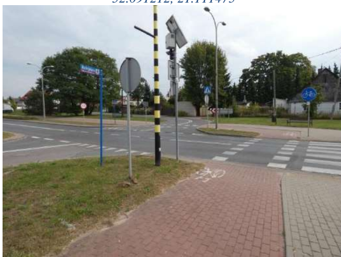
Foto nr 27 [w kierunku południowo-zachodnim] ul. Piaseczyńska [droga dla pieszych i droga dla rowerów, nawierzchnia z kostki betonowej fazowanej szer. – 2,0 m i niefazowanej – szer. 2,5 m] 52.091083, 21.111696
