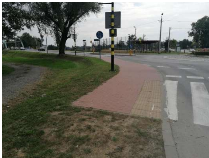
Foto nr 17 [w kierunku południowym] ul. Bielawska rondo z ul. Mirkowską [koniec drogi dla rowerów i pieszych, nawierzchnia z kostki betonowej niefazowanej – szer. 2,3 m] 52.101682, 21.125646
