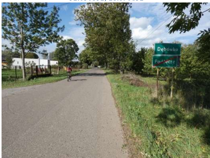
Foto nr 139 [w kierunku północnym] droga gminna m. Podłęczce [ruch rowerowy na zasadach ogólnych, nawierzchnia asfaltowa] 52.043738, 21.196999
