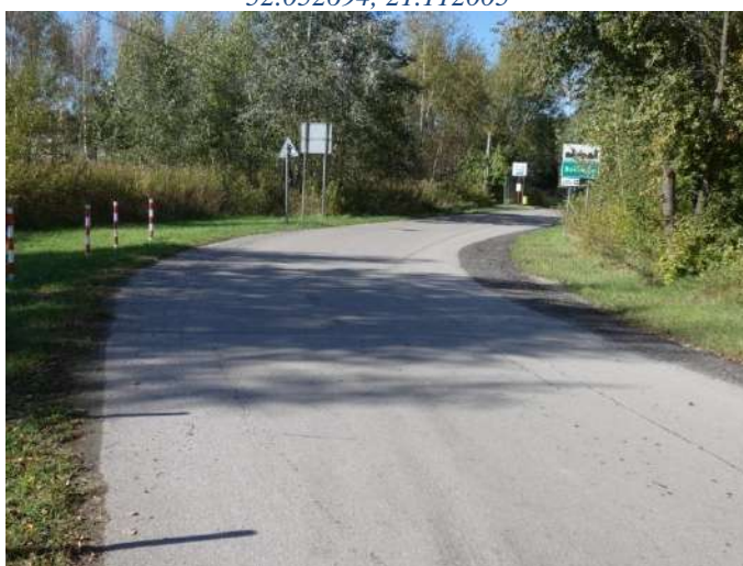
Foto nr 150 [w kierunku zachodnim] ul. Zaleśna [ruch rowerowy na zasadach ogólnych, nawierzchnia asfaltowa] 52.049164, 21.136560
