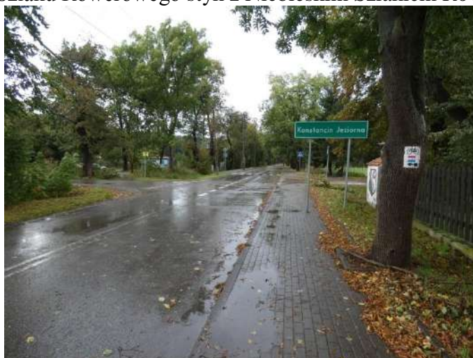
Foto nr 123 [w kierunku północno-zachodnim] ul. Literatów skrzyżowanie z DG w kierunku ul. Wilanowskiej [ruch rowerowy na zasadach ogólnych, nawierzchnia asfaltowa] 52.083428, 21.141803
