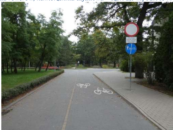
Foto nr 42 [w kierunku północnym] Park Zdrojowy ul. Kraszewskiego [pas ruchu dla rowerów, nawierzchnia asfaltowa – szer. 2,5 m] 52.085869, 21.112226
