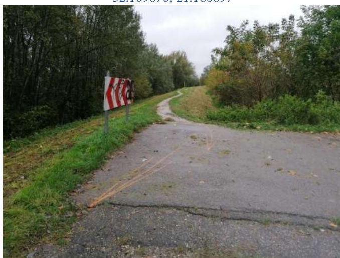
Foto nr 244 b [w kierunku południowym] droga przywałowa w kierunku walu przeciwpowodziowego rzeki Wisły w m. Gassy [nawierzchnia asfaltowa na wale przeciwpowodziowym nawierzchnia gruntowa] 52.080175, 21.206630
