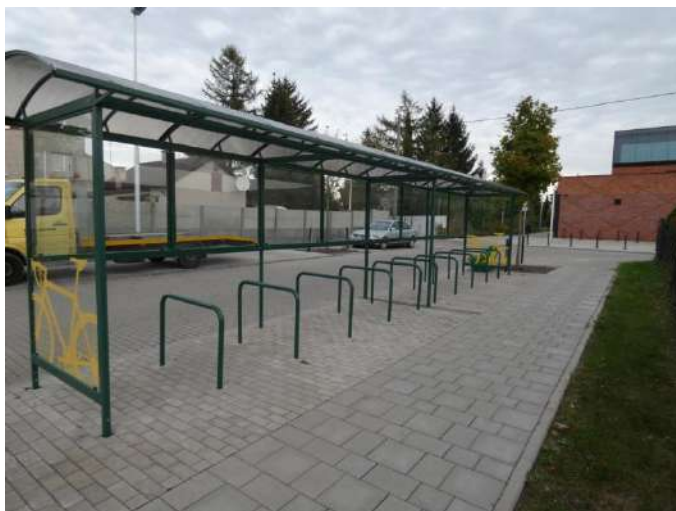
Foto nr 205 [w kierunku południowo-wschodnim] ul. Kolejowa 31 [Parking dla rowerów – 10 stanowisk] 52.093462, 21.114714
