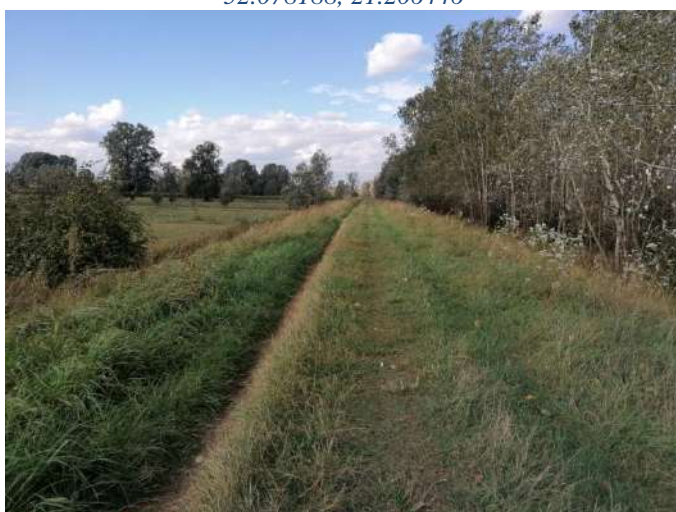
Foto nr 231 [w kierunku północno-zachodnim] na wale przeciwpowodziowym rzeki Wisła w m. Dębówka [nawierzchnia gruntowa] 52.047821, 21.205375
