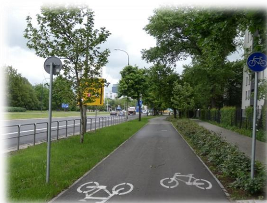
Fotografia 2. Główna komunikacyjna trasa rowerowa. Dwukierunkowa droga dla rowerów, nawierzchnia asfaltowa [oznakowanie pionowe i poziome].
