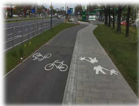
Fotografia 3. Lokalna komunikacyjna trasa rowerowa. Dwukierunkowa droga dla rowerów, nawierzchnia asfaltowa separacja kostka granitową łupaną, droga dla pieszych, nawierzchnia płyty betonowe [oznakowanie pionowe i poziome].
