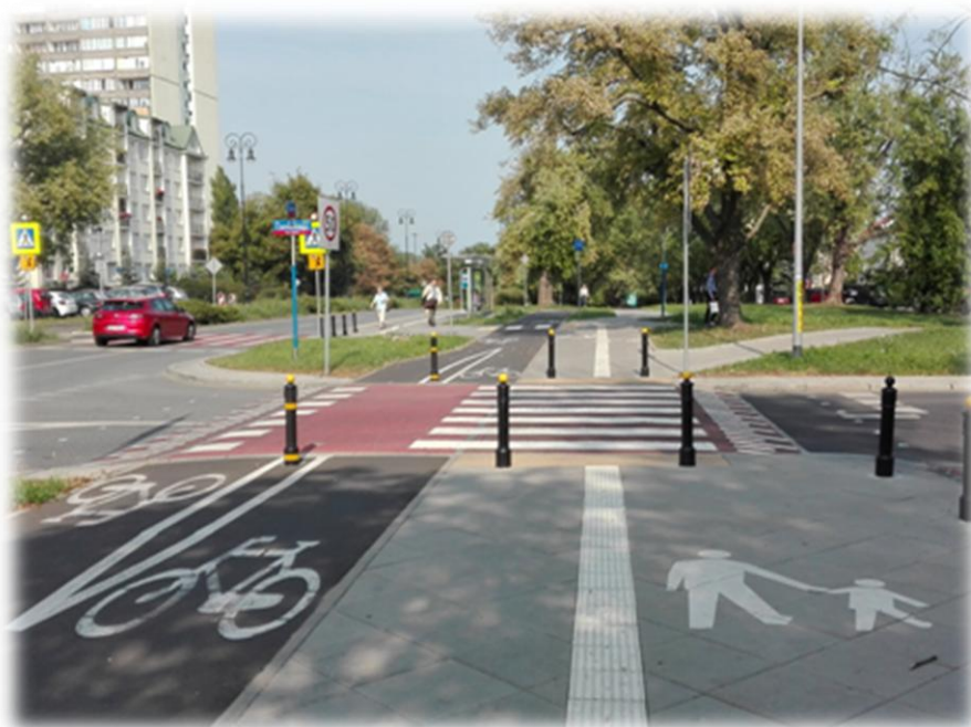
Foto 61. Przejazd dla rowerzystów w barwie czerwonej połączony z przejściem dla pieszych usytuowany na płytowym progę zwalniającym.
