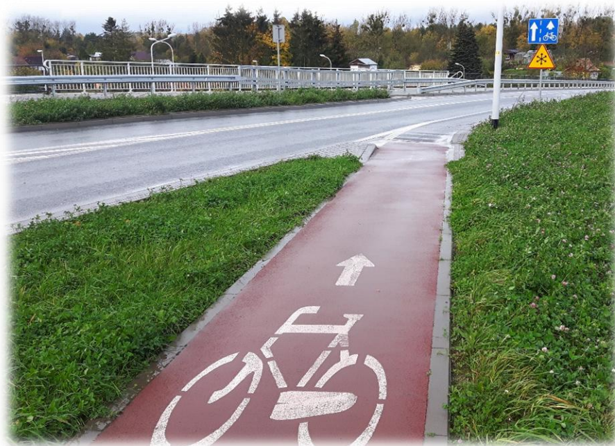
Foto 43. Zjazd z jednokierunkowej drogi dla rowerów (w barwie czerwonej) na jednokierunkowy pas ruchu dla rowerów:
