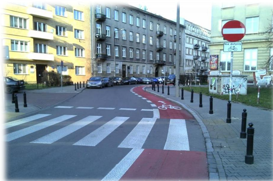
Foto 23. Przykład zastosowania kontrapasa na ulicy jednokierunkowej, barwa czerwona nawierzchni, oznakowanie pionowe i poziome.
