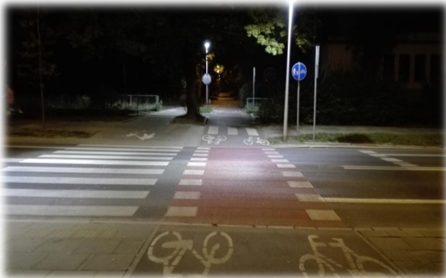
Foto 70. Oświetlenie przejazdu dla rowerzystów i przejścia dla pieszych.
