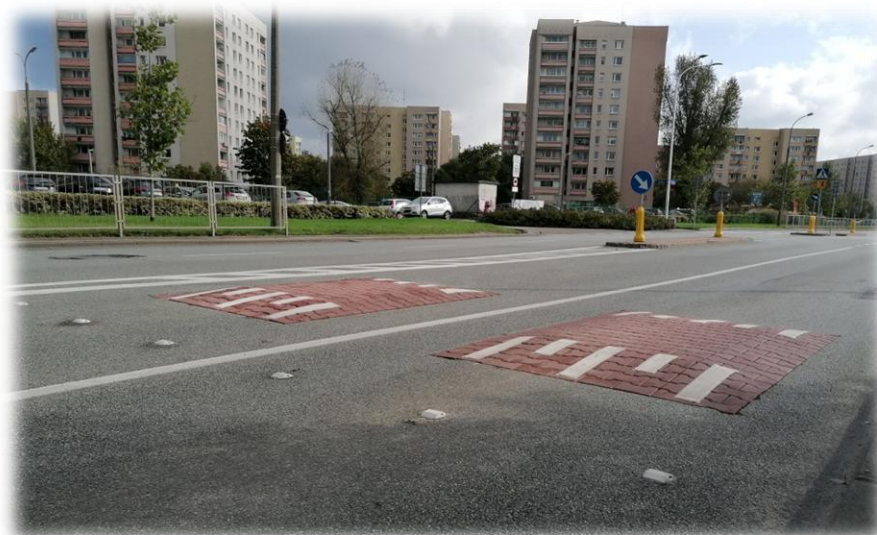
Foto 20. Zastosowanie wolnych przestrzeni dla swobodnego ruchu rowerów przy progach wyspowych w strefie ruchu uspokojonego.
