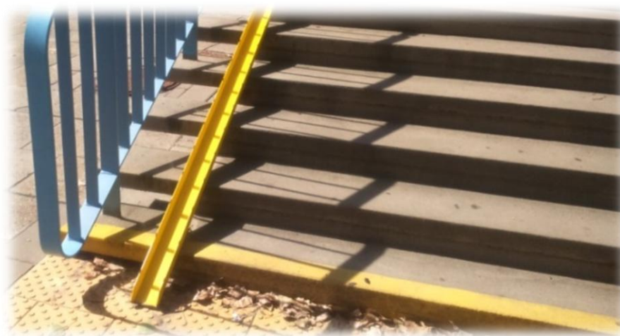
Foto 99. Prowadnica na schodach do prowadzenia roweru.
