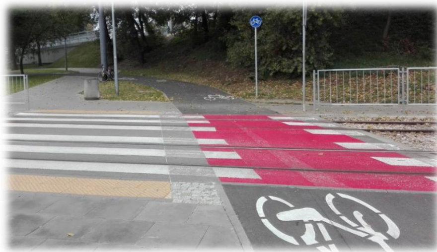
Foto 65. Przejazd dla rowerzystów (barwa czerwona) obok przejścia dla pieszych przez torowisko tramwajowe.
