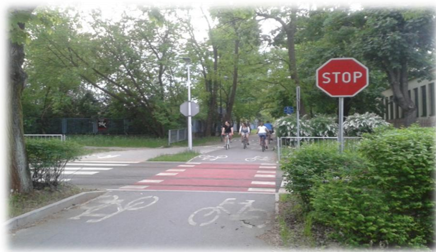
Foto 66. Przejazd dla rowerzystów (barwa czerwona) przez torowisko tramwajowe. Przy drodze dla rowerów zamieszczono znak B-20 „STOP”, ze względu na ograniczenie widoczności na przejeździe.
