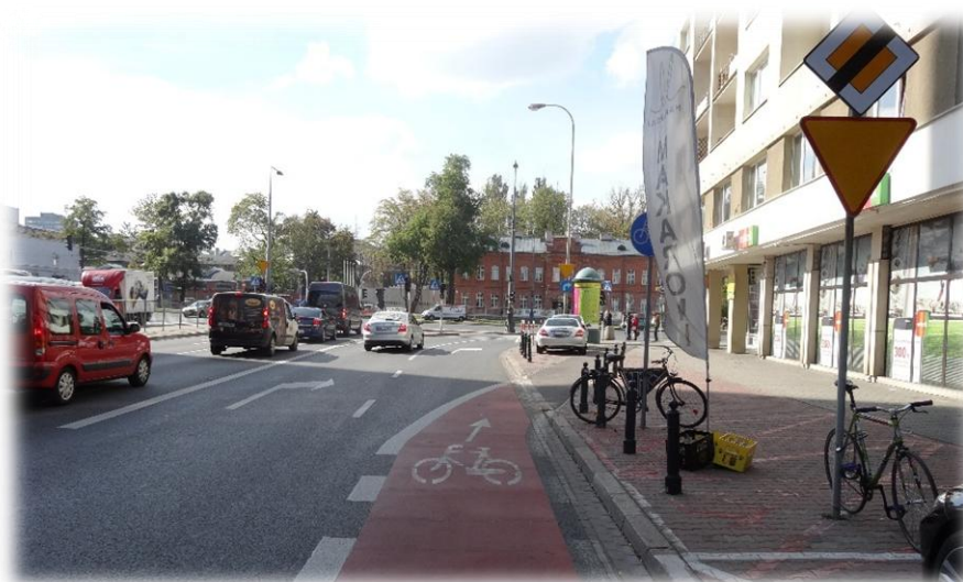
Foto 45. Wjazd z jednokierunkowego pasa ruchu dla rowerów (w barwie czerwonej) na jednokierunkową drogę dla rowerów.
