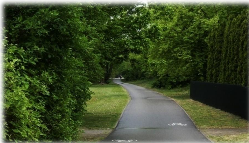
Foto 53. Droga dla rowerów w parku miejskim (dwukierunkowa), szerokość 2,5 m, nawierzchnia asfaltowa.
