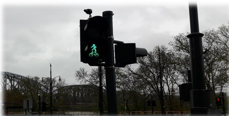
Foto 79. Sygnalizator dwukomorowy dla pieszych i rowerzystów S-5/6. Wświetla sygnały jednocześnie dla pieszych i rowerzystów
