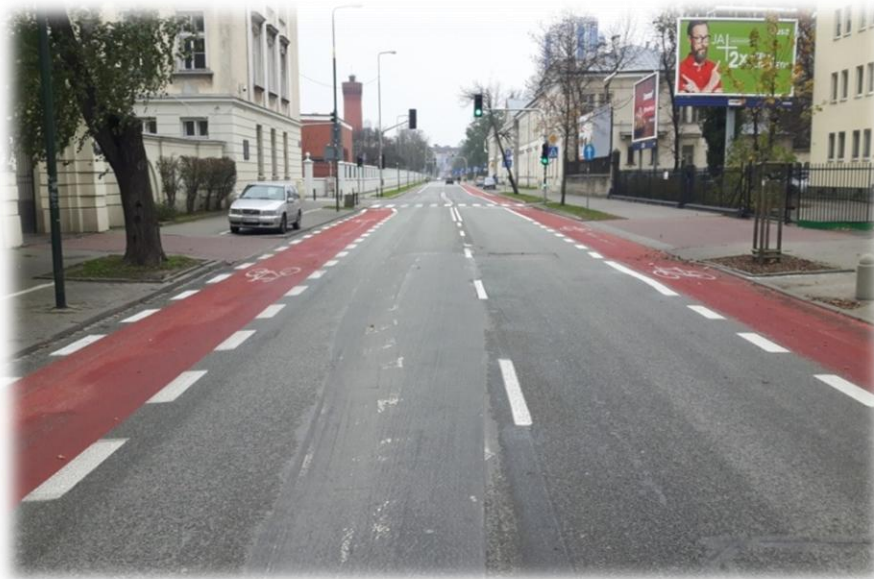
Foto 25. Pasy ruchu dla rowerów (czerwona nawierzchnia) w obszarze zabudowanym.
