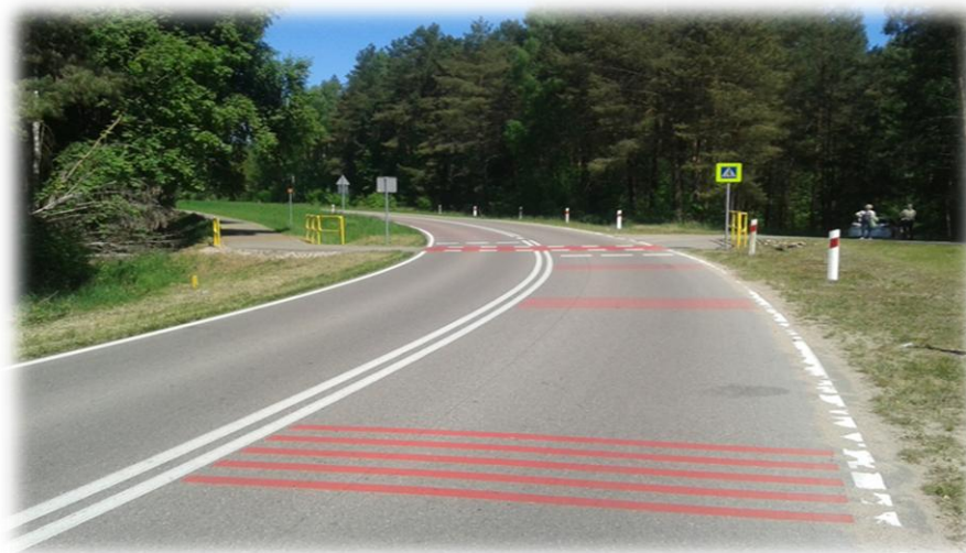
Foto 57. Odcinek dojazdowy do przejazdu dla rowerzystów na drodze poza obszarem zabudowanym z zastosowaniem hamowania optycznego (czerwone pasy poprzeczne).
