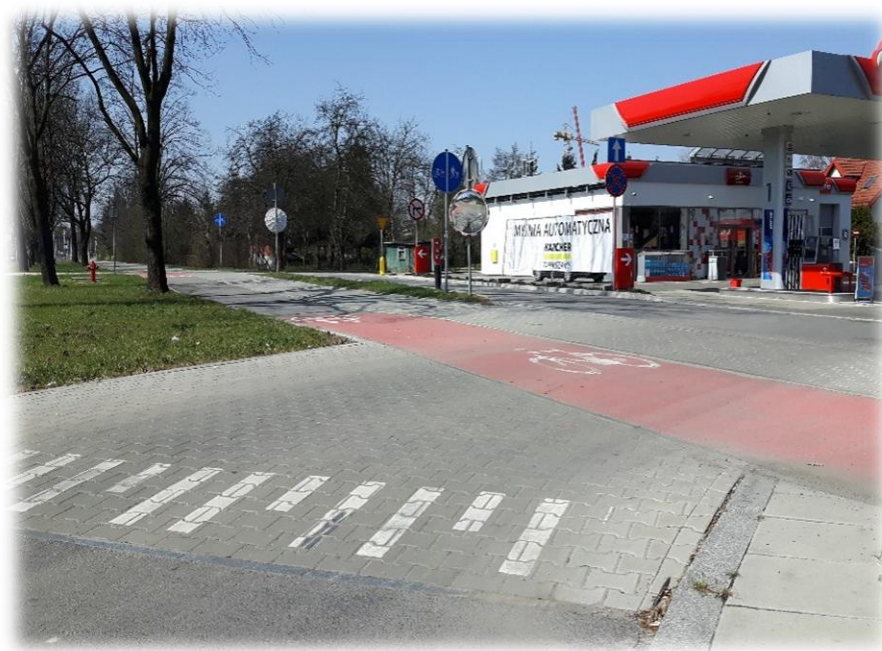
Foto 62. Przejazd dla rowerzystów w barwie czerwonej obok z przejściem dla pieszych usytuowany na płytowym progu zwalniającym.
