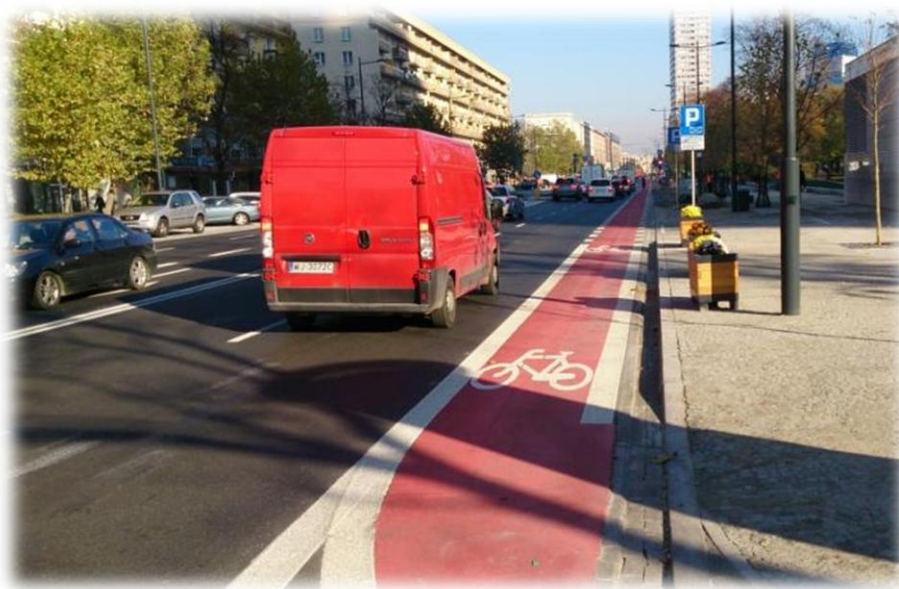
Foto 50. Pas ruchu dla rowerów przy zatoce autobusowej.
