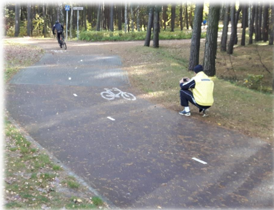
Foto 102. Rowersotrada (dwukierunkowa droga dla rowerów; 4 m szerokości, nawierzchnia asfaltowa), prowadzi wzdłuż Zatoki Gdańskiej.
