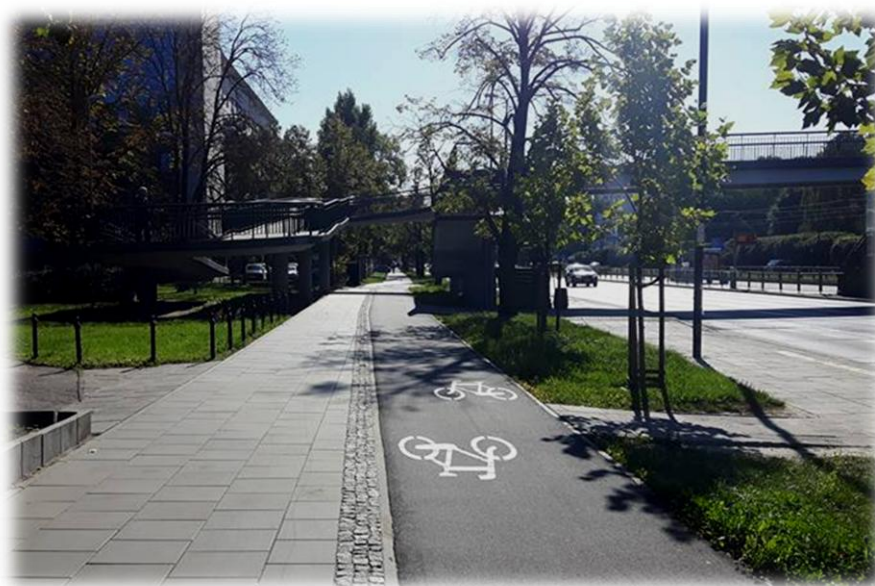
Foto 14. Separacja ruchu rowerowego od pieszego z kostki granitowej.
