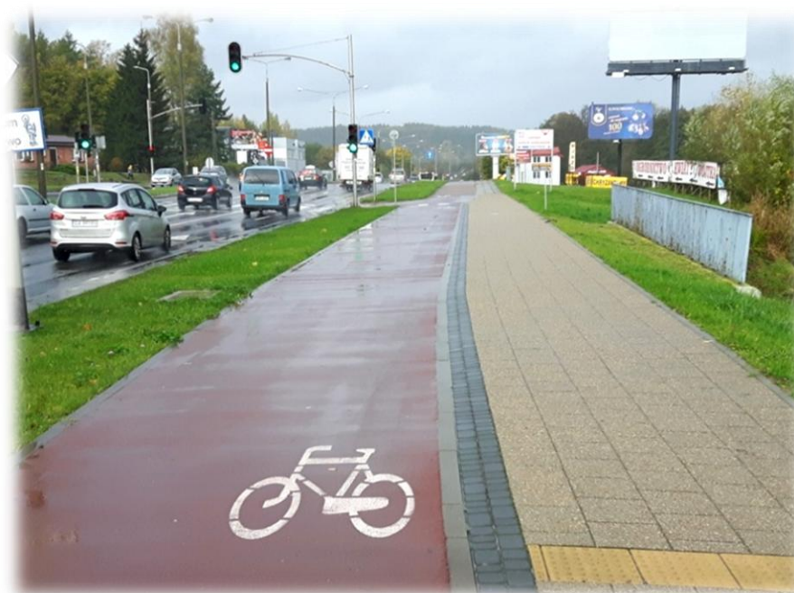
Foto 15 Separacja ruchu rowerowego od pieszego kostką betonową,
