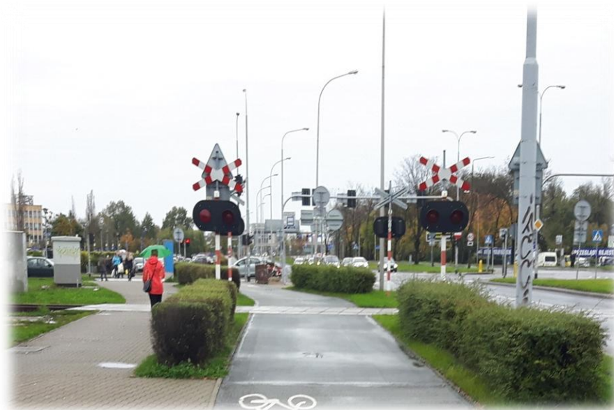
Foto 63. Droga dla rowerów i przejazd dla rowerzystów na przejeździe kolejowym bez zapór z sygnalizacją ostrzegawczą.
