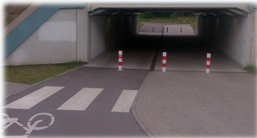
Foto 97. Przepust dostosowany do ruchu rowerowego i pieszego w Warszawie.
