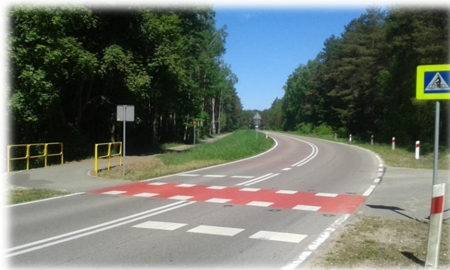
Foto 56. Droga poza obszarem zabudowanym. Przejazd dla rowerzystów w barwie czerwonej oraz znakiem pionowym D-6a „przejazd dla rowerzystów”.
