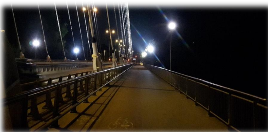
Foto 92. Oświetlenie drogi dla rowerów i drogi dla pieszych na moście.
