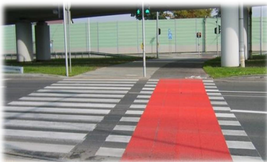
Foto 78. Zastosowanie sygnalizatora dwukomorowego dla pieszych S-5 i dwukomorowy sygnalizator dla rowerzystów S-6 umieszczony na jednym maszcie, po lewej stronie przejazdu dla rowerzystów. Stosuje się sygnał zielony dla pieszych i rowerzystów w tym samym czasie (pomimo technicznej możliwości oddzielnego sterowania tymi dwoma strumieniami).
