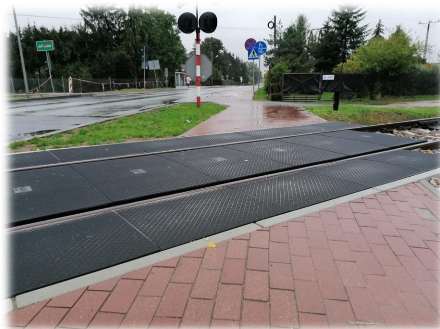
Foto 64. Przejazd dla rowerzystów na przejeździe kolejowym bez zapór.
