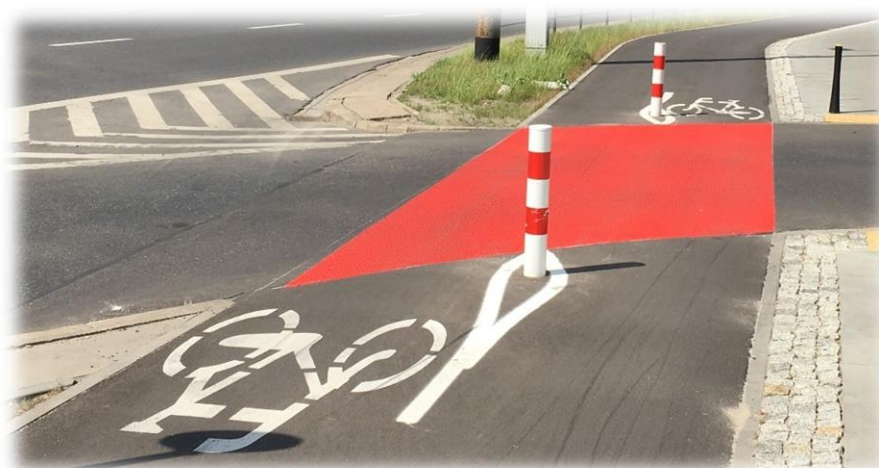
Foto 100. Przykład zastosowania słupków blokujących U 12c na drodze dla rowerów w miejscu, gdzie istnieje ryzyko parkowania samochodów na infrastrukturze dedykowanej rowerzystom.
