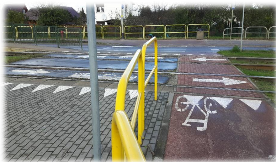
Foto 67. Przejazd dla rowerzystów przez torowisko tramwajowe z barierkami oddzielającymi ruch rowerowy od pieszego.
