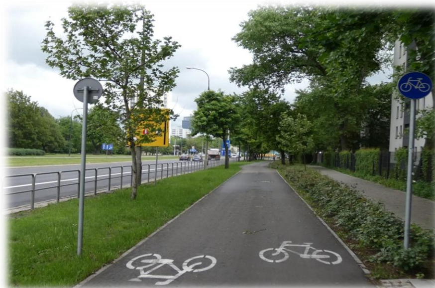
Foto 6. Wydzielona droga dla rowerów – dwukierunkowa (szerokość 2,0 m, oznakowanie pionowe C-13, oznakowanie poziome P-23), zalecana nawierzchnia – asfalt.
