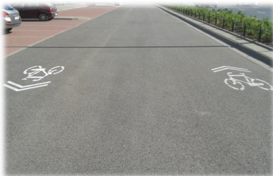
Foto 18. Ruch rowerowy na zasadach ogólnych z zastosowaniem znaku P-27.
