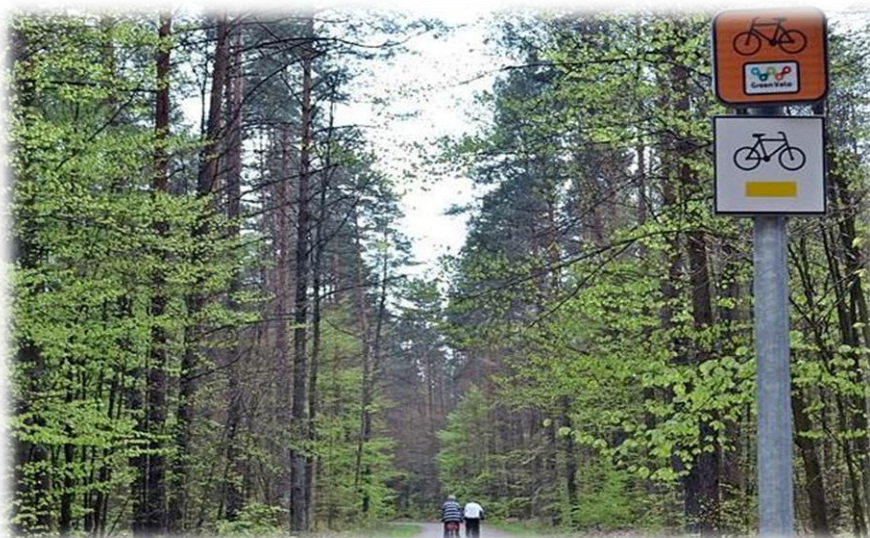
Foto 55. Wschodni Szlak Rowerowy „GreenVelo”, Białowiecki Park Narodowy; 4 m szerokości, oznakowanie typu R, nawierzchnia gruntowa (wzmocniona), źródło: greenvelo.pl.
