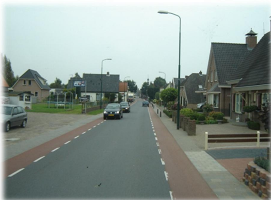
Foto 105. Droga i przekroju 2-1 w Holandii.
