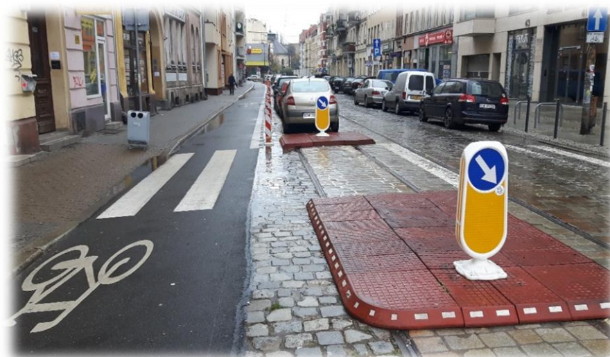
Foto 34. Koniec kontrapasu z zastosowaniem separacji.
