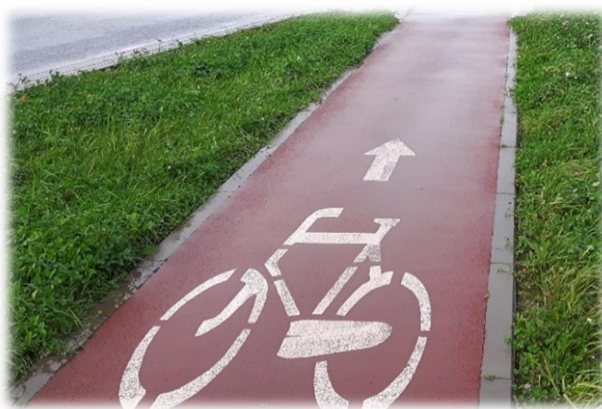
Foto 5. Wydzielona droga dla rowerów – jednokierunkowa (szerokość 1,5 m, nawierzchnia asfaltowa (czerwona), oznakowanie poziome P-23 oraz P-8a strzałka kierunkowa).
