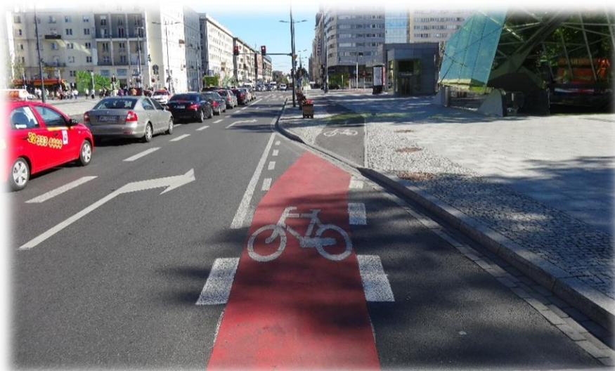
Foto 46. Wjazd z jednokierunkowego pasa ruchu dla rowerów (w barwie czerwonej) na jednokierunkową drogę dla rowerów.
