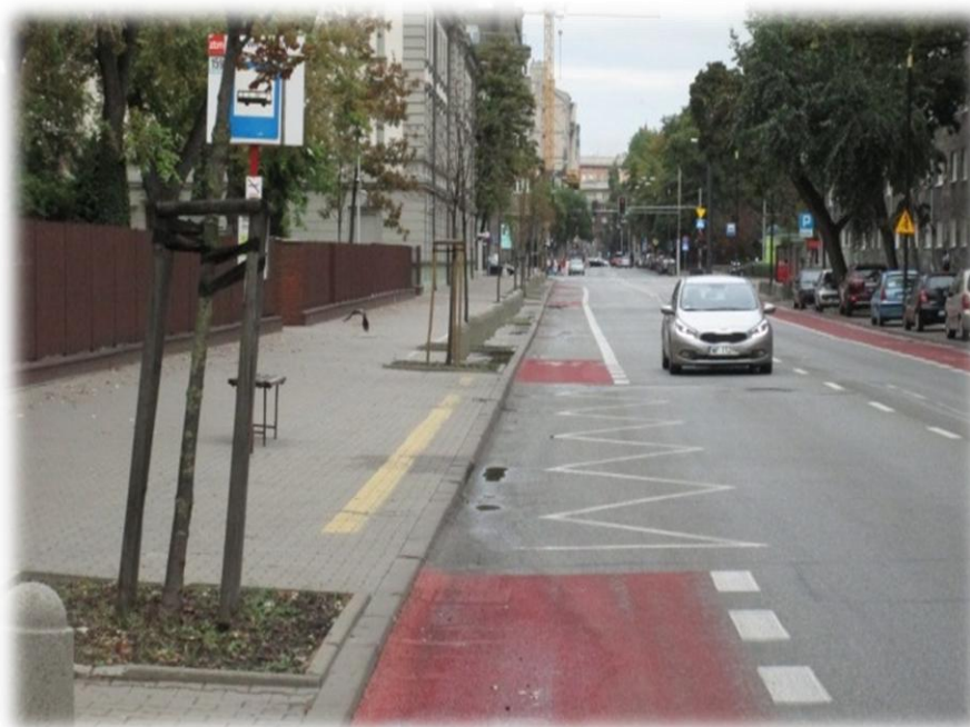
Foto 51. Pas ruchu dla rowerów przy krawężniku z przerwą na przystanek autobusowy.
