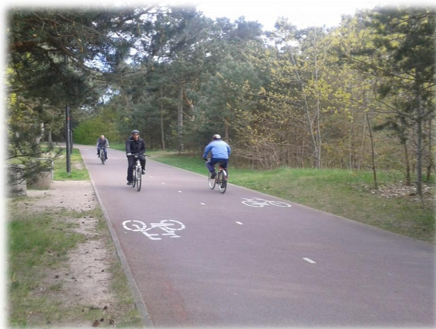
Foto 101. Rowerostrada (dwukierunkowa droga dla rowerów, 4 m szerokości, nawierzchnia asfaltowa), prowadzi wzdłuż Zatoki Gdańskiej (m. Jelitkowo).
