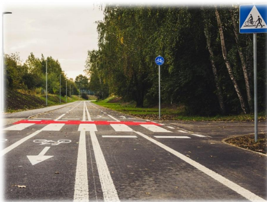
Foto 103. Rowerostrada (dwukierunkowa droga dla rowerów; 2x3 m szerokości, nawierzchnia asfaltowa) w mieście Jaworzno. Źródło: Urząd Miejski w Jaworznie.
