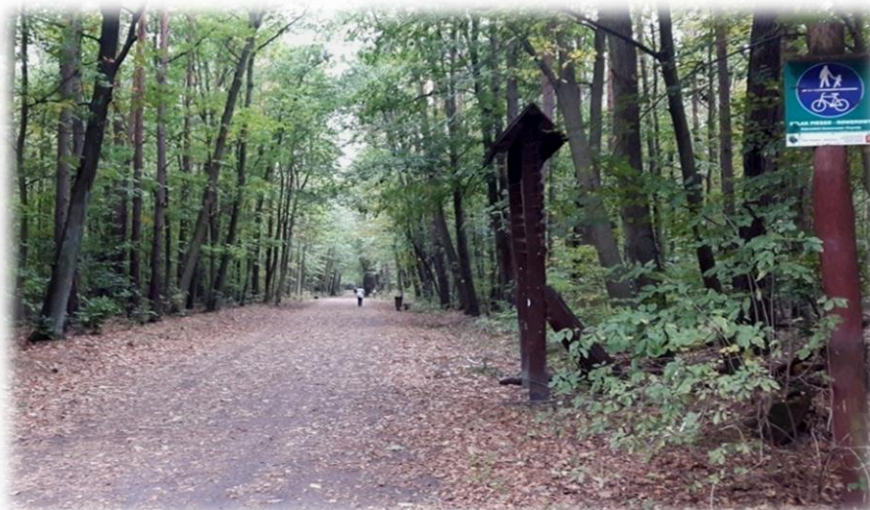
Foto 54. Szlak pieszo-rowerowy w lesie miejskim (szerokość 5 m), nawierzchnia gruntowa. Wspólny szlak pieszo-rowerowy można realizować, ale w przypadku zastosowania odpowiednich parametrów szerokości (min. 4 szerokości, zaleca się 5 m szerokości).
