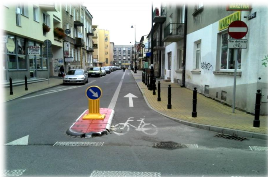
Foto 24. Kontrapas, oddzielony od pozostałej części jezdni linią ciągłą, z oznakowaniem pionowym i poziomym i zastosowaniem słupka przeszkodowego U-5b.
