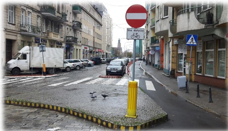
Foto 33. Początek kontrapasa z zastosowaniem separacji ruchu.
