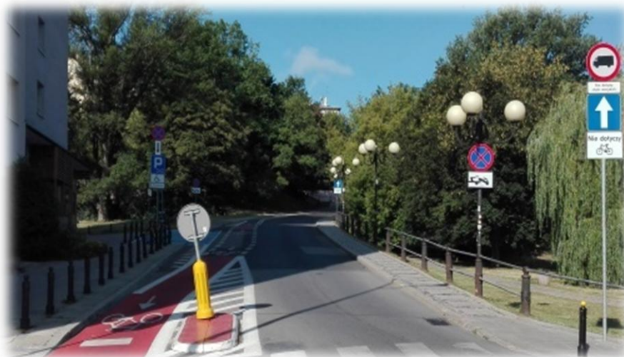
Foto 31. Koniec kontrapasa, wlot na skrzyżowanie (znaki pionowe: D-3 „droga jednokierunkowa”, tabliczka T-22 „nie dotyczy rowerów” umieszczona pod znakami).
