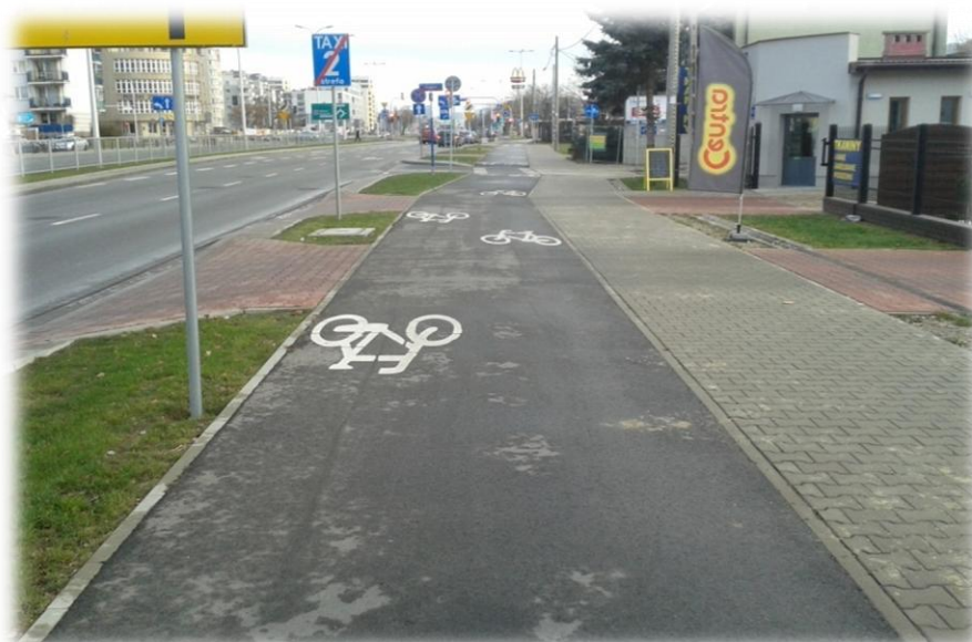
Foto 8. Przykład prawidłowo zaprojektowanej drogi dla rowerów przy wjeździe do posesji. Droga dla rowerów powinna być równa, także przy wjazdach do posesji.
