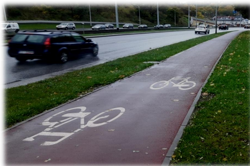
Foto 7. Wydzielona droga dla rowerów – dwukierunkowa (szerokość 2,0 m, oznakowanie poziome P-23), nawierzchnia – asfalt w kolorze czerwonym (rozwiązanie wzorowane na standardach holenderskich).
