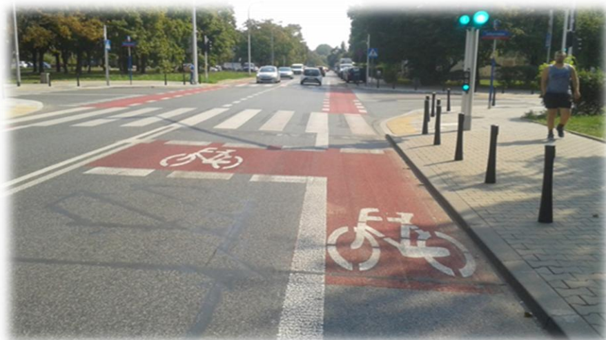
Foto 29. Śluza dla rowerów na jednopasowym wlocie na skrzyżowaniu. Na śluzę naprowadza prasy ruchu dla rowerów umieszczony przy prawej krawędzi jezdni. W śluzie umieszczono znak poziomy P- 23 „rower”.
