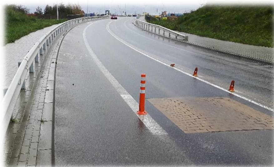
Foto 21. Ruch rowerowy w strefie ruchu uspokojonego z zastosowaniem pasa ruchu dla rowerów. Przykład z miasta Gdańsk. Rozwiązanie powszechnie stosowane w Danii, Holandii, Belgii.
