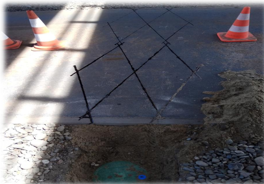
Foto 93. Montaż pętli indukcyjnej w drodze dla rowerów (nawierzchnia asfaltowa).
