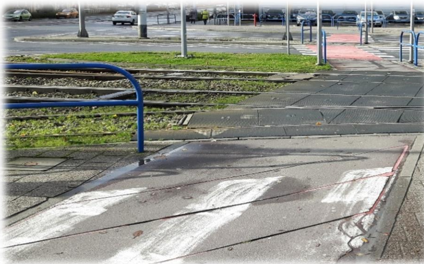
Foto 76. Detektor automatyczny dla rowerzystów z pętlą indukcyjną wbudowana w drogę dla rowerów
