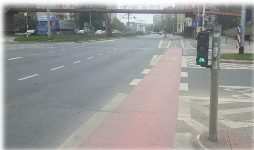
Foto 77. Zastosowanie sygnalizatora przy pasie ruchu dla rowerów
