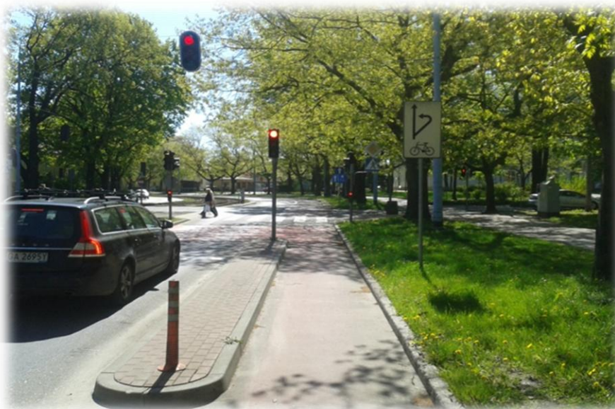
Foto 38. Pas ruchu dla rowerów naprowadzający na służę (azyl dla rowerzystów), który umożliwia skręt w lewo (z sygnalizacją świetlną) i separacją ruchu. Tęgo typu rozwiązanie zapewnia zdecydowanie większe bezpieczeństwo rowerzystom.
