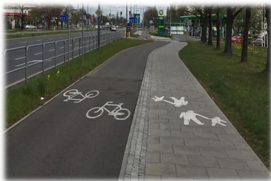
Foto nr 3. Lokalna komunikacyjna trasa rowerowa. Dwukierunkowa droga dla rowerów, nawierzchnia asfaltowa separacja kostka granitową lupaną, droga dla pieszych, nawierzchnia płyty betonowe [oznakowanie pionowe i poziome].
