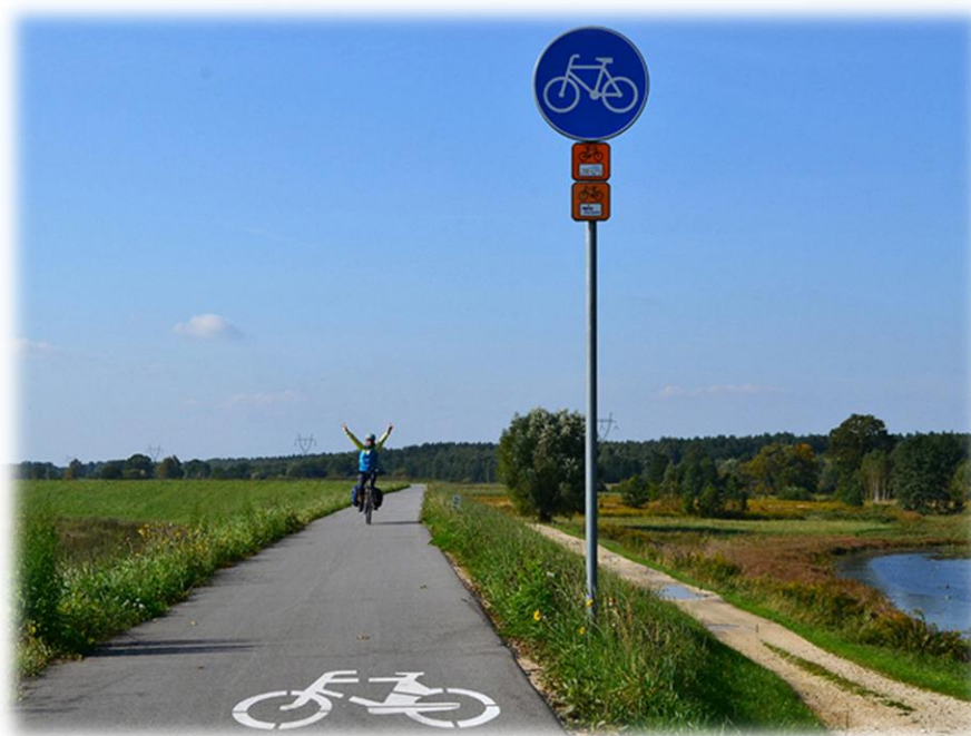
Foto nr 1. Wiślana Trasa Rowerowa (krajowa). Dwukierunkowa droga dla rowerów, nawierzchnia asfaltowa [oznakowanie pionowe i poziome].
