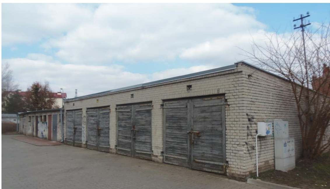
Fotografia 2 Budynek garażowy przy ul. Jaworskiego
