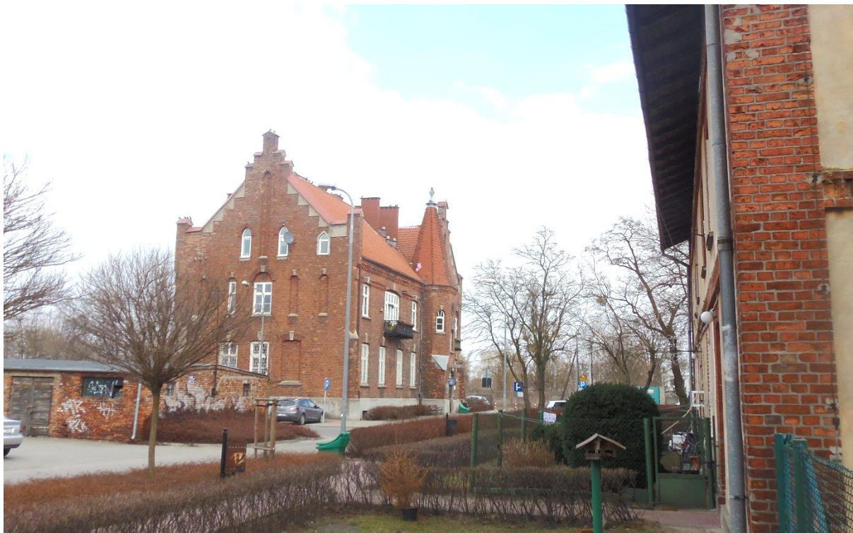
Fotografia 3 Budynek usługowo-mieszkalny przy ul. Mirkowskiej 56 (w układzie urbanistycznym osiedla)
