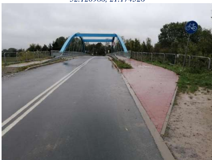
Foto nr 241 [w kierunku północno-zachodnim] droga dla rowerów przed mostem na Jeziorce w m. Obórki [nawierzchnia z kostki betonowej niefazowanej] 52.120597, 21.175352
