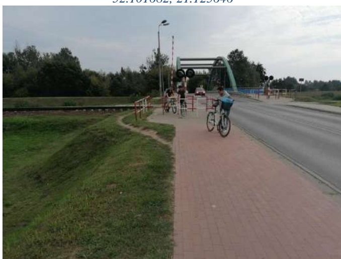
Foto nr 18a [w kierunku wschodnim] ul. Mirkowska [droga dla rowerów i pieszych, nawierzchnia z kostki betonowej niefazowanej – szer. 2,3 m, przechodząca przez przejazd kolejowy i most nad Jeziorką] 52.101237, 21.126507
