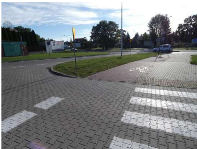
Foto nr 104 [w kierunku południowo-wschodnim] ul. Torowa w kierunku ul. Piaseczyńskiej [droga dla pieszych i droga dla rowerów, nawierzchnia z kostki betonowej fazowanej szer. – 2,0 m i niefazowanej – szer. 2,5 m] 52.091199, 21.111504
