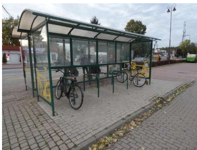
Foto nr 197 [w kierunku zachodnim] ul. Warszawska 36 [Parking dla rowerów – 10 stanowisk] 52.096600, 21.116878
