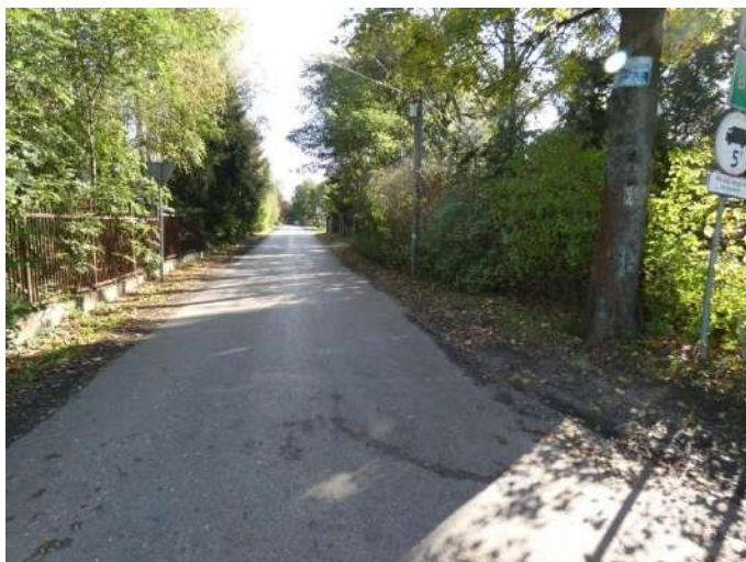
Foto nr 149 [w kierunku wschodnim] ul. Zaleśna [ruch rowerowy na zasadach ogólnych, nawierzchnia asfaltowa] 52.052694, 21.112005
