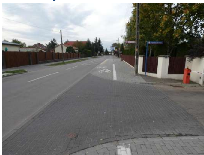
Foto nr 77 [w kierunku północnym] ul. Powsińska skrzyżowanie z ul. Ogrody Bielawy [droga dla rowerów i pieszych, nawierzchnia z kostki betonowej niefazowanej – szer. 3,5 m] 52.107348, 21.130774
