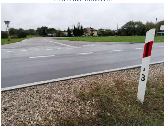
Foto nr 245 [w kierunku północno-wschodnim] DW 712 skrzyżowanie z DG w m. Gassy [nawierzchnia asfaltowa] 52.081211, 21.200457
