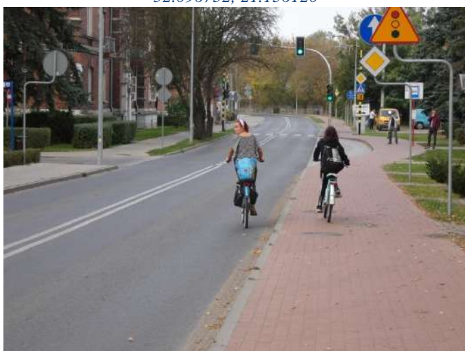
Foto nr 24 [w kierunku północnym] ul. Mirkowska [droga dla rowerów i pieszych, nawierzchnia z kostki betonowej niefazowanej – szer. 2,3 m] 52.096413, 21.136329
