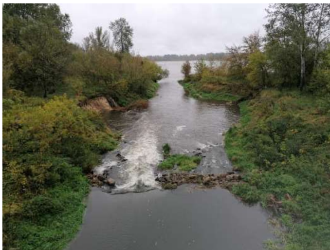
Foto nr 239 [w kierunku północno-wschodnim] widok z mostu ujście Jeziorki do Wisły w m. Obórki 52.120859, 21.174660
