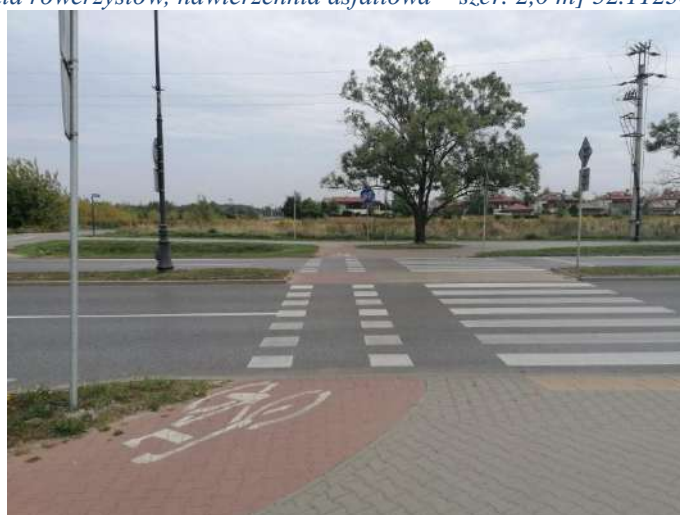
Foto nr 3 [w kierunku wschodnim] ul. Warszawska [zjazd z drogi dla rowerów, nawierzchnia z kostki betonowej fazowanej na przejazd dla rowerzystów, nawierzchnia asfaltowa – szer. 2,0 m] 52.112223, 21.110529
