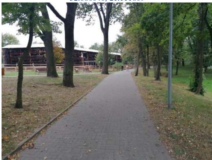
Foto nr 37 [w kierunku zachodnim] Park Zdrojowy Aleja Pisogne na wysokości Tężni Solankowej [droga dla rowerów i pieszych, nawierzchnia z kostki betonowej niefazowanej – szer. 3,1 m] 52.086341, 21.113790
