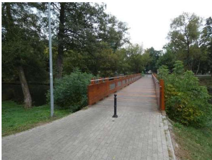
Foto nr 48 [w kierunku południowo-wschodnim] Park Zdrojowy widok na most Parkowy na Jeziorce [droga dla rowerów i pieszych, nawierzchnia z kostki betonowej niefazowanej – szer. 2,0 m] 52.086435, 21.111190
