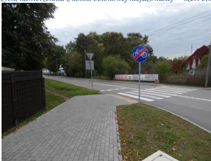
Foto nr 74 [w kierunku zachodnim] ul. Lipowa skrzyżowanie z ul. Bielawską [droga dla rowerów i pieszych, nawierzchnia z kostki betonowej niefazowanej – szer. 3,0 m] 52.106465, 21.128969
