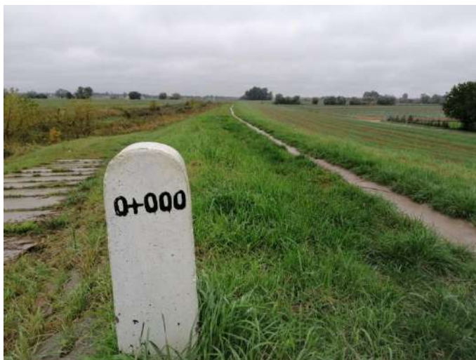
Foto nr 237 [w kierunku południowym] wał przeciwpowodziowy wzdłuż Jeziorki w okolicy mostu ujścia Jeziorki do Wisły [nawierzchnia gruntowa] 52.120863, 21.174042
