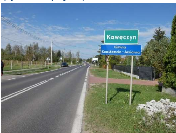
Foto nr 233 [w kierunku południowym] DW 734 ul. Wilanowska 52.038180, 21.176841
