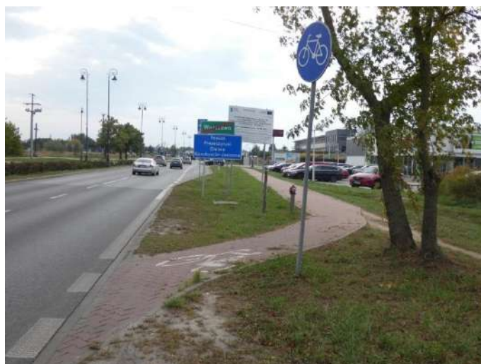
Foto nr 1 [w kierunku południowym] ul. Warszawska (granica z m. st. Warszawa) [wjazd z jezdni na drogę dla rowerów - nawierzchnia z kostki betonowej fazowanej – szer. 2,0 m] 52.113140, 21.109649
