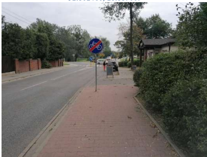
Foto nr 15 [w kierunku wschodnim] ul. Mirkowska [droga dla rowerów i pieszych, nawierzchnia z kostki betonowej niefazowanej – szer. 2,3 m] 52.101624, 21.124549
