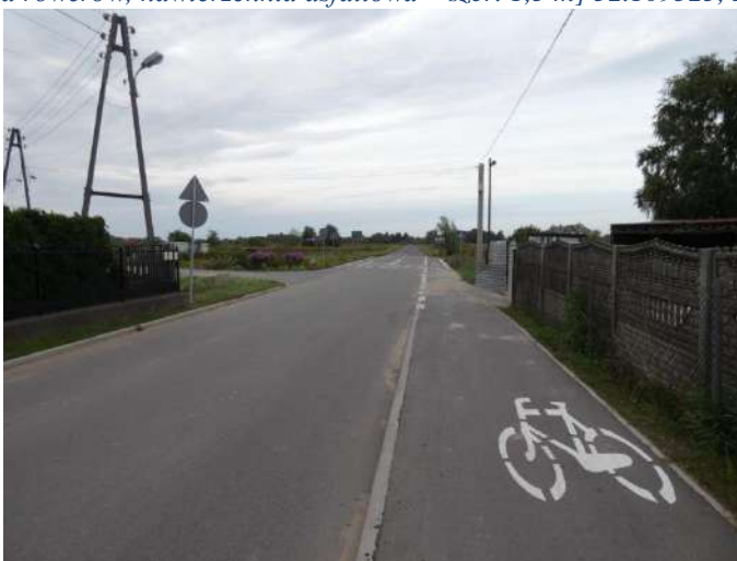
Foto nr 87 [w kierunku północnym] ul. Okrzewska [droga dla rowerów, nawierzchnia asfaltowa – szer. 1,5 m] 52.110343, 21.131907
