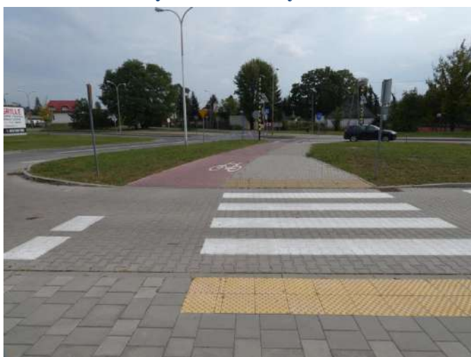
Foto nr 26 [w kierunku południowo-wschodnim] ul. Torowa w kierunku ul. Piaseczyńskiej [droga dla pieszych i droga dla rowerów, nawierzchnia z kostki betonowej fazowanej szer. – 2,0 m i niefazowanej – szer. 2,5 m] 52.091212, 21.111475
