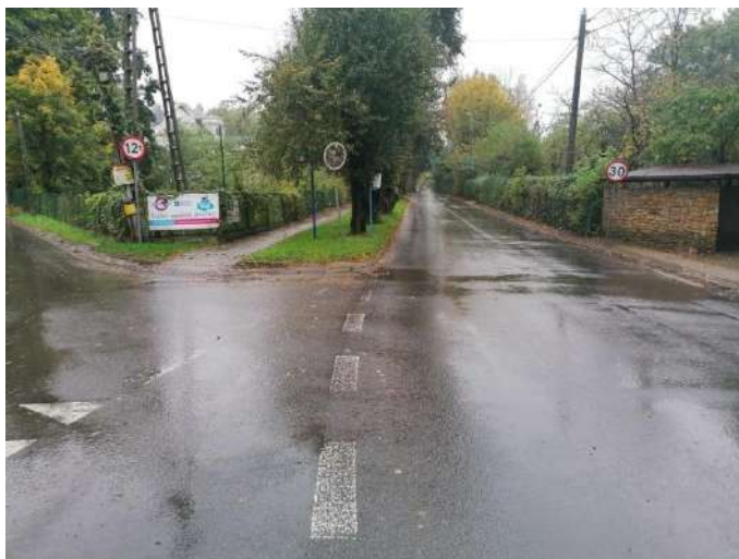
Foto nr 236 [w kierunku północnym] ul. Głowackiego skrzyżowanie z ul. Śniadeckich, 52.087906, 21.073885
