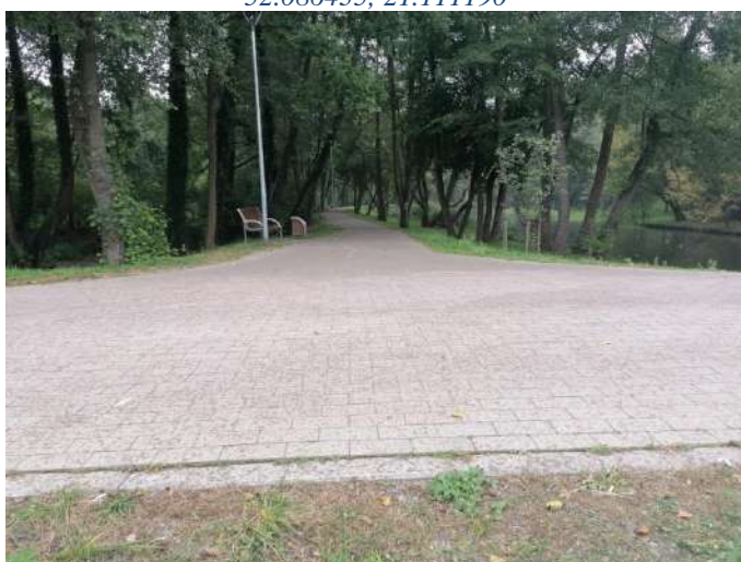
Foto nr 49 [w kierunku północno-wschodnim] Park Zdrojowy wzdłuż Jeziorki w kierunku ul. Warszawskiej [droga dla rowerów i pieszych, nawierzchnia z kostki betonowej niefazowanej – szer. 3,0 m] 52.086435, 21.111157
