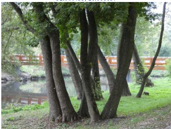
Foto nr 51 [w kierunku południowo-zachodnim] Park Zdrojowy wzdłuż Jeziorki widok na most Parkowy na Jeziorce [droga dla rowerów i pieszych, nawierzchnia z kostki betonowej niefazowanej – szer. 3,0 m] 52.086542 21.111356
