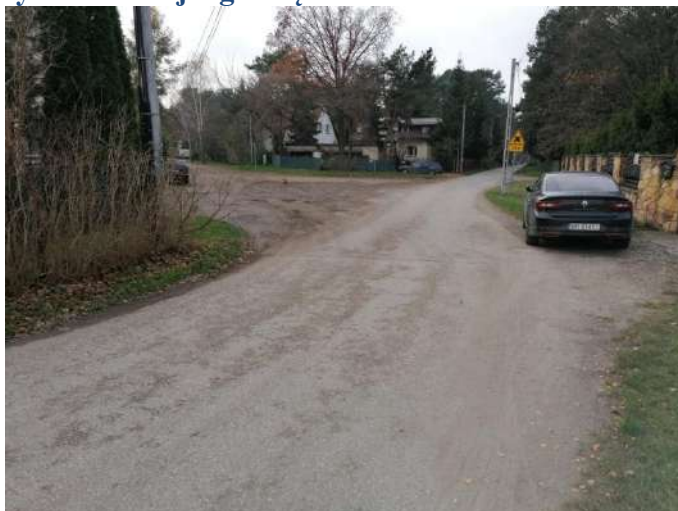
Foto nr 256 [w kierunku północno-zachodnim] ul. Wierzbnowska w kierunku ul. Piaskowej 52.072851, 21.079781
