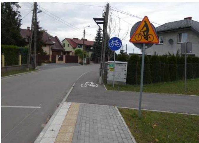
Foto nr 85 [w kierunku północnym] ul. Okrzewska [droga dla rowerów, nawierzchnia asfaltowa – szer. 1,5 m] 52.109325, 21.131464
