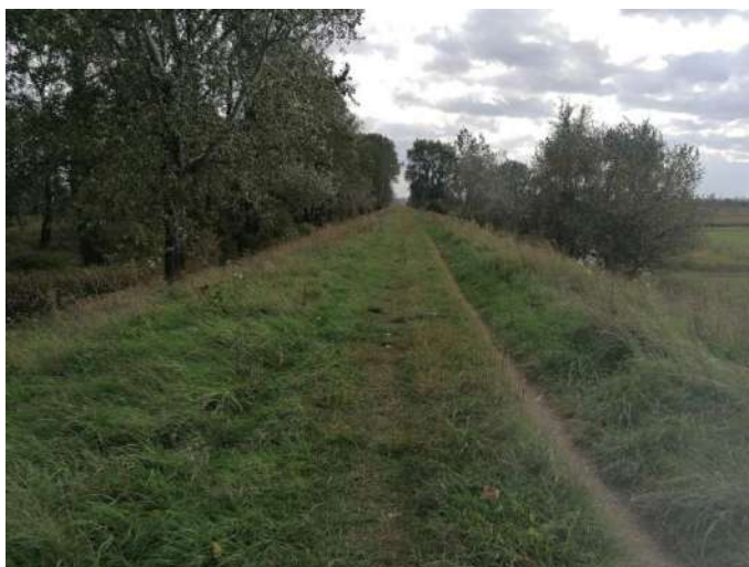
Foto nr 232 [w kierunku południowo-wschodnim] na wale przeciwpowodziowym rzeki Wisła 52.047821, 21.205375
