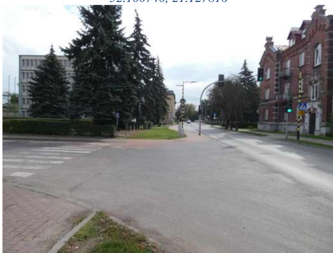
Foto nr 21 [w kierunku południowym] ul. Mirkowska [droga dla rowerów i pieszych, nawierzchnia z kostki betonowej niefazowanej – szer. 2,3 m, brak przejazdu dla rowerzystów przez jezdnię] 52.096961, 21.135784
