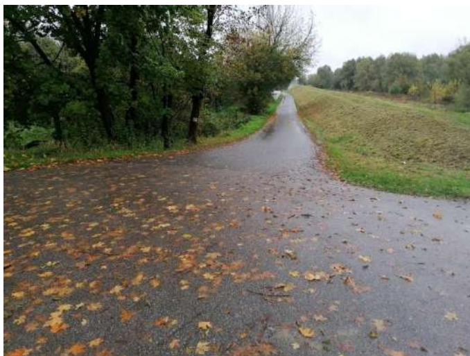
Foto nr 244a [w kierunku północnym] droga przywałowa w m. Gassy [nawierzchnia asfaltowa] 52.080165, 21.206515
