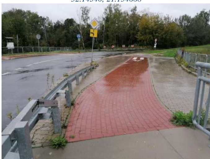
Foto nr 240 [w kierunku północno-zachodnim] droga dla rowerów za mostem na Jeziorce w m. Obórki [nawierzchnia z kostki betonowej niefazowanej] 52.120986, 21.174326
