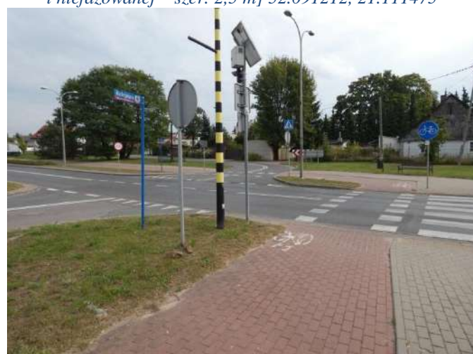
Foto nr 27 [w kierunku południowo-zachodnim] ul. Piaseczyńska [droga dla pieszych i droga dla rowerów, nawierzchnia z kostki betonowej fazowanej szer. – 2,0 m i niefazowanej – szer. 2,5 m] 52.091083, 21.111696
