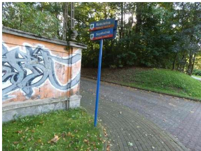
Foto nr 177 [w kierunku południowo-wschodnim] Bulwar im. prof. Jana Hafika skrzyżowanie z ul. Szpitalną [ruch rowerowy na zasadach ogólnych, nawierzchnia z kostki betonowej fazowanej] 52.082871, 21.104645
