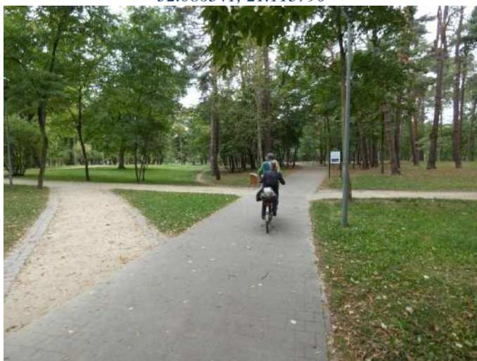
Foto nr 36 [w kierunku północnym] Park Zdrojowy Aleja Pisogne [droga dla rowerów i pieszych, nawierzchnia z kostki betonowej niefazowanej – szer. 3,1 m] 52.086414, 21.117762
