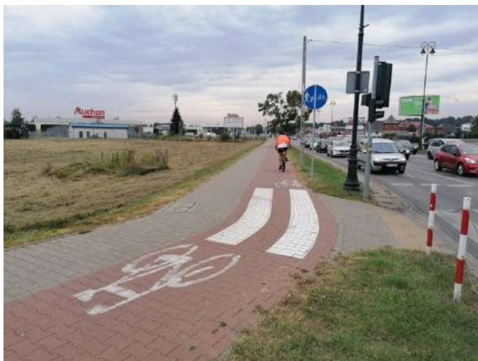
Foto nr 8 [w kierunku południowym] ul. Warszawska [droga dla pieszych i droga dla rowerów, nawierzchnia z kostki betonowej fazowanej szer. – 1,5 m i niefazowanej – szer. 2,0 m] 52.109673, 21.113215
