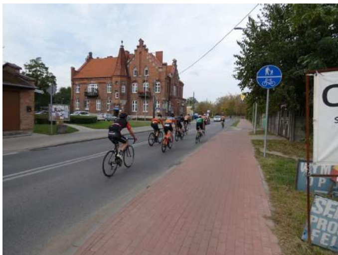
Foto nr 22 [w kierunku północnym] ul. Mirkowska [droga dla rowerów i pieszych, nawierzchnia z kostki betonowej niefazowanej – szer. 2,3 m] 52.097011, 21.135890
