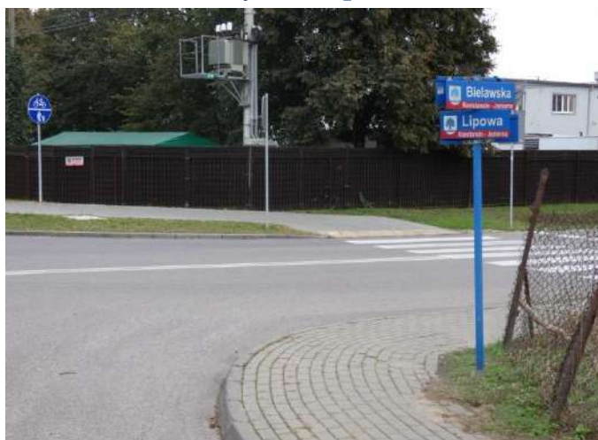
Foto nr 73 [w kierunku wschodnim] ul. Lipowa skrzyżowanie z ul. Bielawską [droga dla rowerów i pieszych, nawierzchnia z kostki betonowej niefazowanej – szer. 3,0 m] 52.106379, 21.128736
