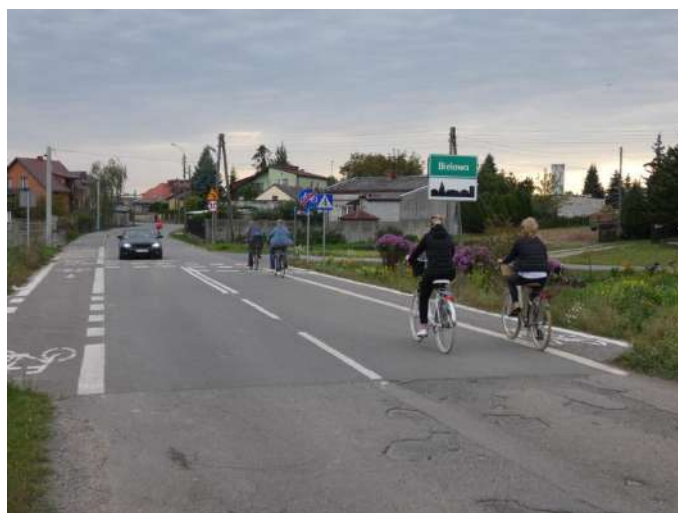
Foto nr 89 [w kierunku południowym] ul. Okrzewska [pasy ruchu dla rowerów, nawierzchnia asfaltowa – szer. 1,5 m] 52.110745, 21.132052
