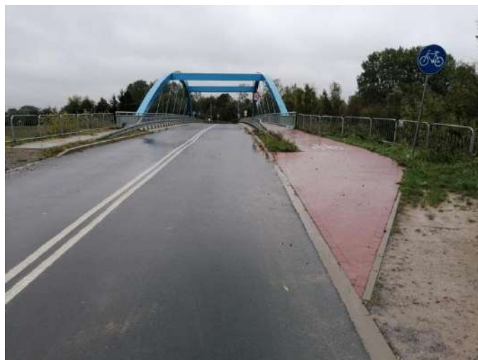
Foto nr 241 [w kierunku północno-zachodnim] droga dla rowerów przed mostem ujścia Jeziorki do Wisły [ nawierzchnia z kostki betonowej niefazowanej] 52.120597, 21.175352
