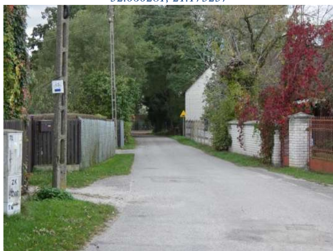
Foto nr 130 [w kierunku południowo-zachodnim] droga gminna w m. Cieciszew [ruch rowerowy na zasadach ogólnych, nawierzchnia asfaltowa] 52.059681, 21.178896
