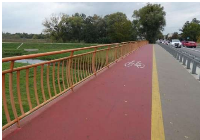
Foto nr 58 [w kierunku północno-zachodnim] ul. Warszawska most nad Jeziorką [droga dla pieszych i droga dla rowerów, nawierzchnia betonowa-żywiczna szer. 2,0 m + szer. 2,5 m] 52.091003, 21.120615
