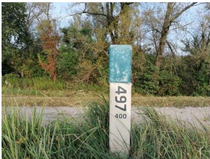
Foto nr 228 [w kierunku wschodnim] na wale przeciwpowodziowym rzeki Wisła [nawierzchnia gruntowa] 52.14340, 21.154668
