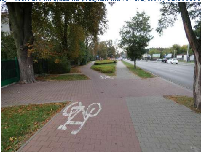
Foto nr 10 [w kierunku południowym] ul. Warszawska [droga dla pieszych i droga dla rowerów przechodzi w drogę dla rowerów, nawierzchnia z kostki betonowej niefazowanej – szer. 2,0 m] 52.104575, 21.114095
