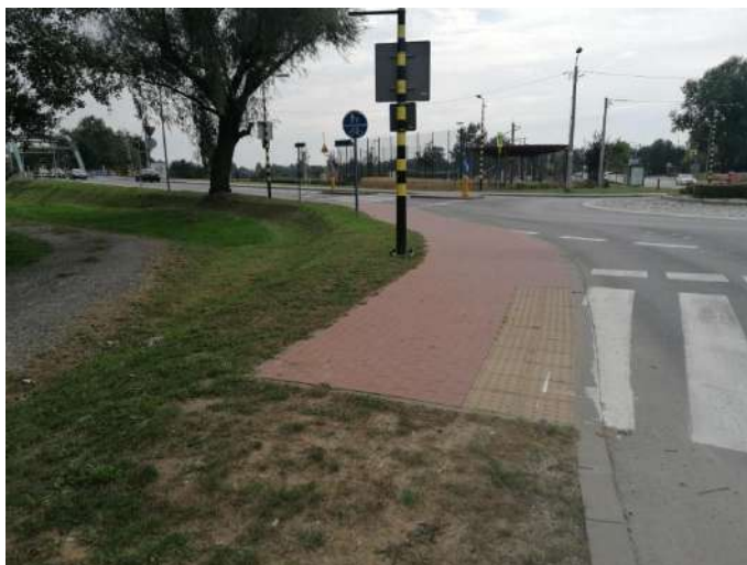
Foto nr 17 [w kierunku południowym] ul. Bielawska rondo z ul. Mirkowską [koniec drogi dla rowerów i pieszych, nawierzchnia z kostki betonowej niefazowanej – szer. 2,3 m] 52.101682, 21.125646
