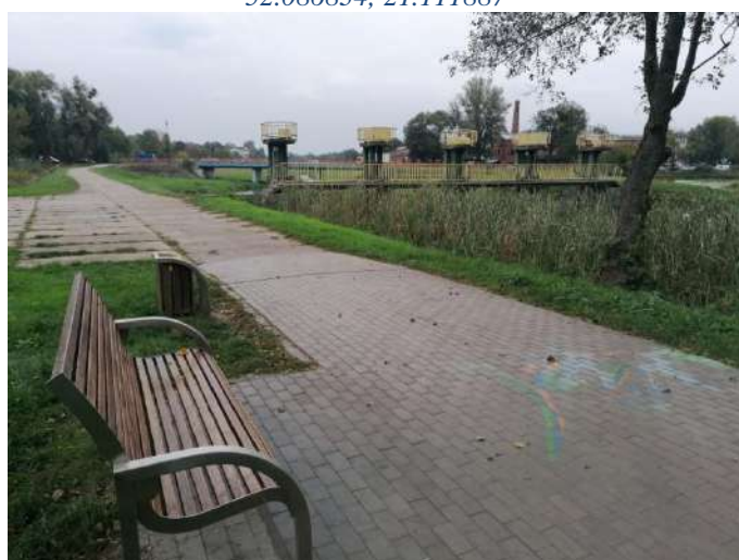
Foto nr 53 [w kierunku północnym] wzdłuż Jeziorki w kierunku ul. Warszawskiej na wysokości grobli [droga dla rowerów i pieszych, nawierzchnia z kostki betonowej niefazowanej – szer. 3,0 m] 52.090188, 21.119170
