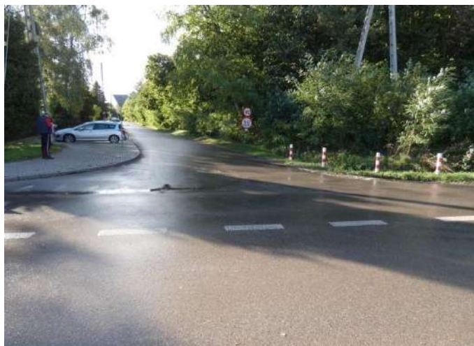
Foto nr 171 [w kierunku zachodnim] ul. Akacyjowa skrzyżowanie z ul. Chylicką [ruch rowerowy na zasadach ogólnych, nawierzchnia asfaltowa] 52.067831, 21.099812
