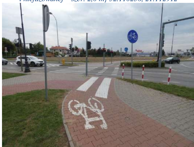
Foto nr 7 [w kierunku południowym] ul. Warszawska [zjazd z drogi dla rowerów o nawierzchni z kostki betonowej fazowanej na przejazd dla rowerzystów, nawierzchnia asfaltowa – szer. 2,0 m] 52.110159, 21.113107
