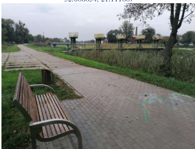
Foto nr 53 [w kierunku północnym] wzdłuż Jeziorki w kierunku ul. Warszawskiej na wysokości grobli [droga dla rowerów i pieszych, nawierzchnia z kostki betonowej niefazowanej – szer. 3,0 m] 52.090188, 21.119170
