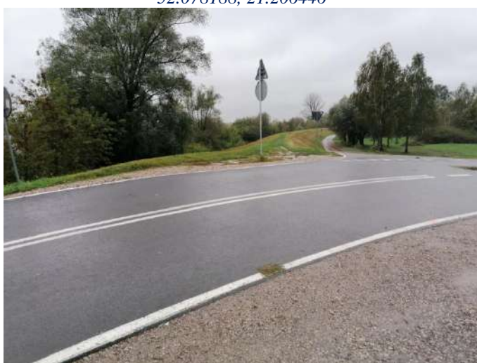
Foto nr 247b [w kierunku południowym] DW 712 widok na wał przeciwpowodziowy rzeki Wisły w m. Gassy [nawierzchnia asfaltowa, na wale przeciwpowodziowym nawierzchnia gruntowa] 52.078188, 21.206446
