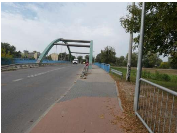
Foto nr 19 [w kierunku zachodnim] ul. Mirkowska [droga dla rowerów i pieszych, nawierzchnia z kostki betonowej niefazowanej – szer. 2,3 m] 52.100759, 21.127744
