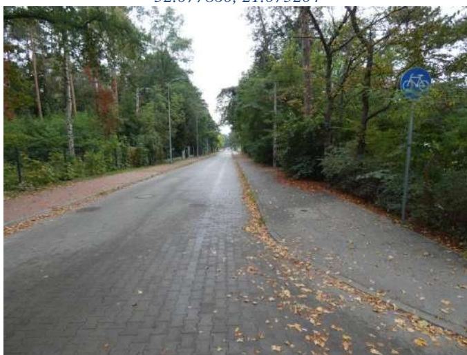
Foto nr 63 [w kierunku południowym] ul. Przesmyckiego skrzyżowanie z ul. Broniewskiego [droga dla rowerów, nawierzchnia asfaltowa – szer. 2,0 m] 52.080094, 21.075182
