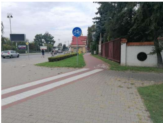
Foto nr 11 [w kierunku północnym] ul. Warszawska [droga dla rowerów, nawierzchnia z kostki betonowej niefazowanej – szer. 2,0 m] 52.102856, 21.114630
