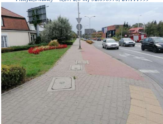
Foto nr 30 [w kierunku południowo-zachodnim] ul. Piaseczyńskiej na wysokości z ul. Warszawską [droga dla pieszych i droga dla rowerów, nawierzchnia z kostki betonowej fazowanej szer. – 2,0 m i niefazowanej – szer. 2,5 m] 52.093752, 21.117546
