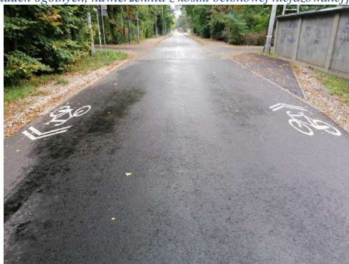
Foto nr 65 [w kierunku południowym] ul. Grechuty (gmina Piaseczno) w kierunku ul. Przesmyckiego [ruch rowerów na zasadach ogólnych, nawierzchnia asfaltowa, zastosowanie znaku poziomego P-27 „kierunek i tor ruchu roweru” – szer. 5,0 m] 52.080259, 21.075181
