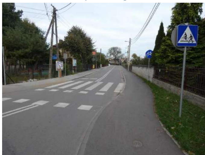
Foto nr 82 [w kierunku wschodnim] ul. Wspólna [droga dla rowerów, nawierzchnia asfaltowa – szer. 1,5 m] 52.108544, 21.130170
