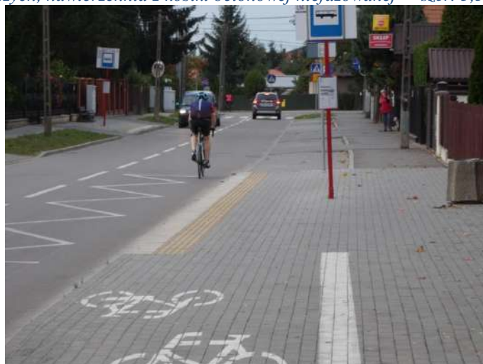
Foto nr 78 [w kierunku wschodnim] ul. Lipowa skrzyżowanie z ul. Powsińską [droga dla rowerów i pieszych, nawierzchnia z kostki betonowej niefazowanej – szer. 3,5 m] 52.107737, 21.130546
