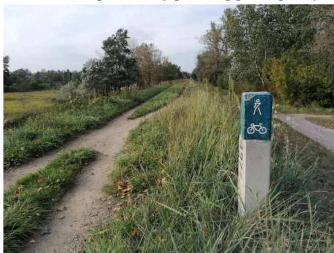
Foto nr 227[w kierunku północnym] na wale przeciwpowodziowym rzeki Wisła w m. Kępa Falenicka na 497,400 km rzeki Wisły [nawierzchnia gruntowa] 52.14340, 21.154668
