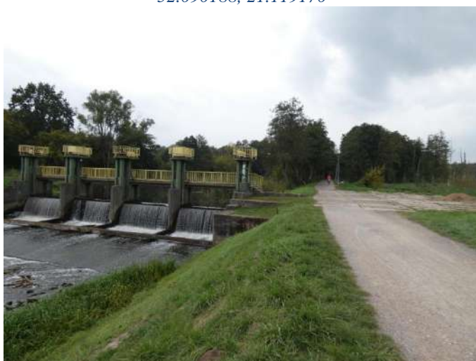
Foto nr 54 [w kierunku południowym] widok na Jaz Imberfal wzdłuż Jeziorki w kierunku Parku Zdrojowego [droga dla rowerów i pieszych, nawierzchnia gruntowa – szer. 3,5 m] 52.090643, 21.119453
