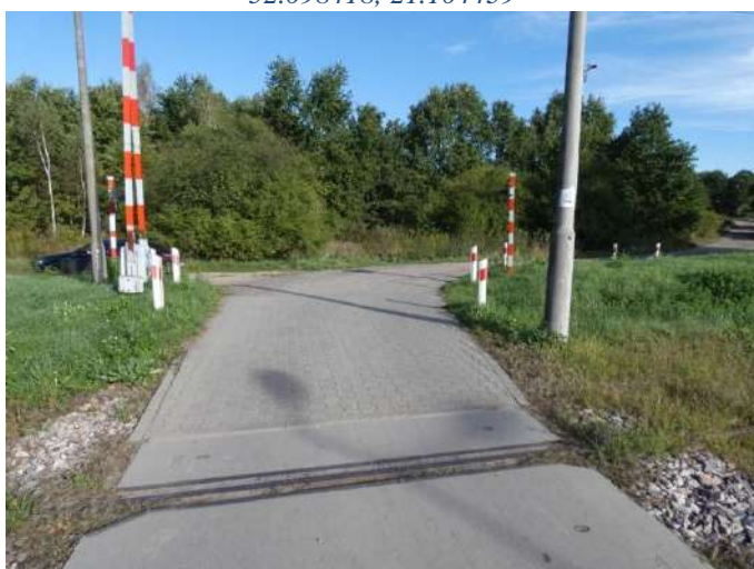
Foto nr 100 [w kierunku północnym] ul. Saneczkowa przejazd strzeżony przez tory kolejowe [ruch rowerowy na zasadach ogólnych, nawierzchnia kostka betonowa + płyty betonowe] 52.094992, 21.102750
