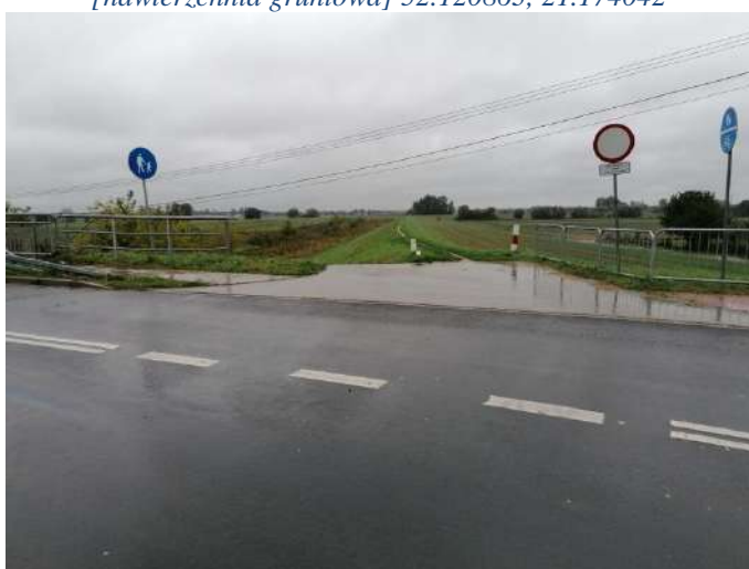
Foto nr 238 [w kierunku południowym] droga gminna widok na wał przeciwpowodziowy wzdłuż Jeziorki w okolicy mostu ujścia Jeziorki do Wisły [nawierzchnia asfaltowa] 52.121065, 21.174090
