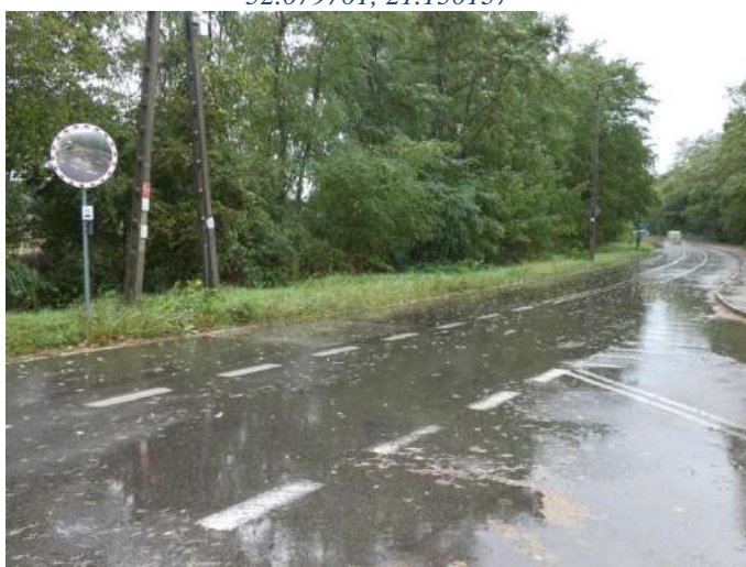
Foto nr 126 [w kierunku północnym] ul. Baczyńskiego skrzyżowanie z ul. Podlaską w m. Obory [ruch rowerowy na zasadach ogólnych, nawierzchnia asfaltowa] 52.075407, 21.152906
