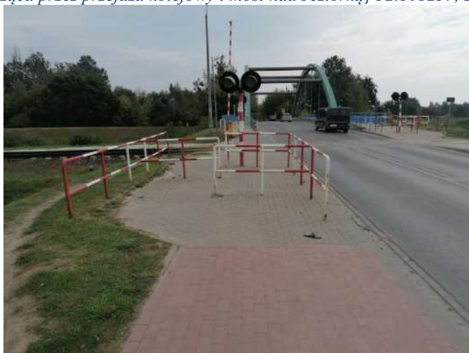
Foto nr 18b [w kierunku wschodnim] ul. Mirkowska, przejazd przez tory kolejowe [droga dla rowerów i pieszych, nawierzchnia z kostki betonowej niefazowanej – szer. 2,3 m, przechodząca przez przejazd kolejowy i most nad Jeziorką] 52.101237, 21.126507
