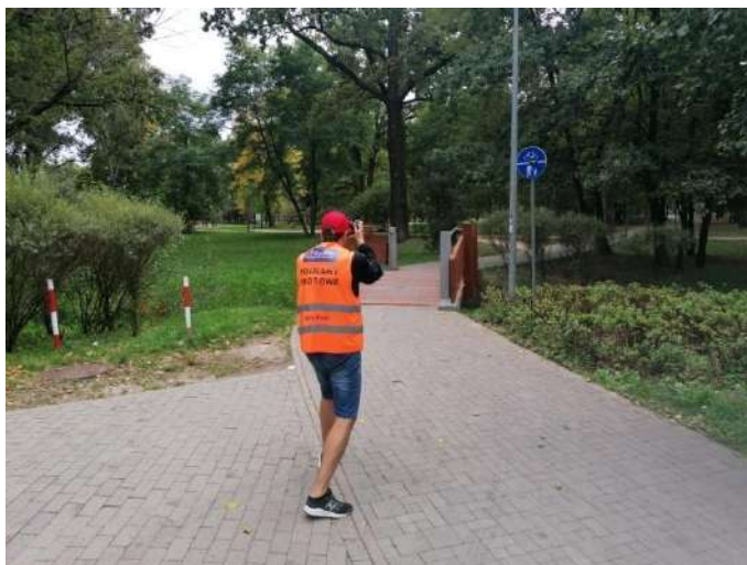
Foto nr 34 [w kierunku zachodnim] Park Zdrojowy od ul. Matejki w kierunku Tężni Solankowej [droga dla rowerów i pieszych, nawierzchnia z kostki betonowej niefazowanej – szer. 3,1 m] 52.086596, 21.118310
