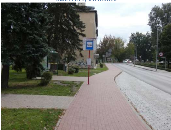
Foto nr 23 [w kierunku południowym] ul. Mirkowska [droga dla rowerów i pieszych, nawierzchnia z kostki betonowej niefazowanej – szer. 2,3 m] 52.096732, 21.136120
