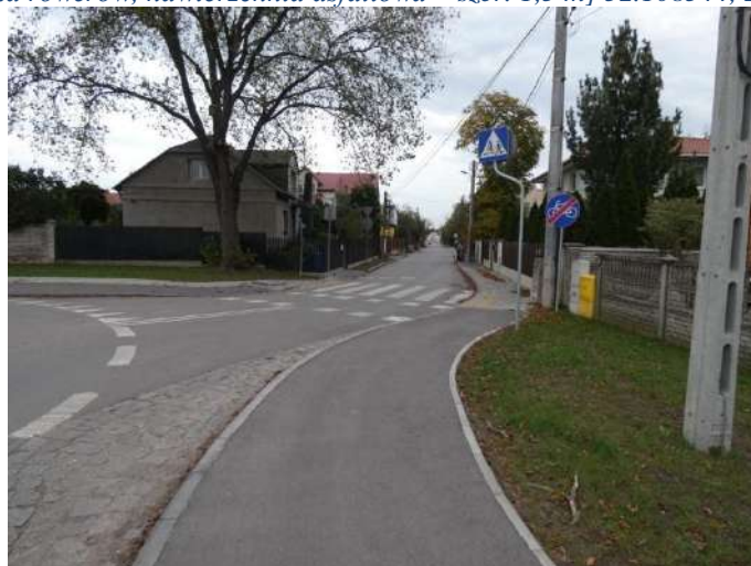
Foto nr 83 [w kierunku wschodnim] ul. Wspólna [droga dla rowerów, nawierzchnia asfaltowa – szer. 1,5 m] 52.108829, 21.131416
