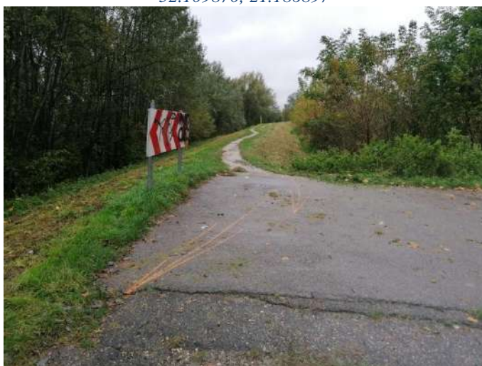
Foto nr 244 b [w kierunku południowym] droga przywałowa w kierunku wału przeciwpowodziowego rzeki Wisły w m. Gassy [nawierzchnia asfaltowa na wale przeciwpowodziowym nawierzchnia gruntowa] 52.080175, 21.206630
