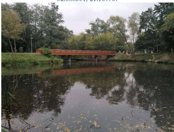
Foto nr 50 [w kierunku wschodnim] Park Zdrojowy widok na most Parkowy na Jeziorce [droga dla rowerów i pieszych, nawierzchnia drewniana – szer. 2,0 m] 52.086339, 21.110842
