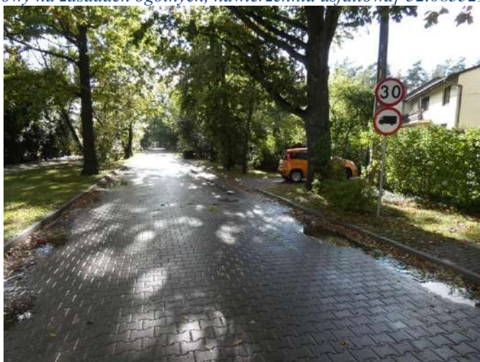
Foto nr 164 [w kierunku południowo-zachodnim] ul. Do Lasu [ruch rowerowy na zasadach ogólnych, nawierzchnia kostka betonowa fazowana] 52.078917, 21.132341
