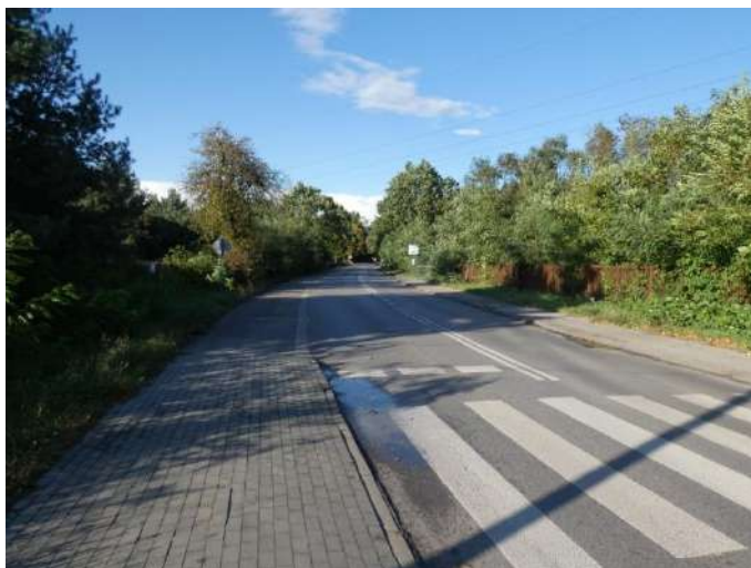
Foto nr 70 [w kierunku północnym] ul. Warecka [droga dla rowerów i pieszych – nawierzchnia z kostki betonowej, przechodzi w pas ruchu dla rowerów, nawierzchnia asfaltowa – szer. 2,5 m] 52.052897, 21.111836
