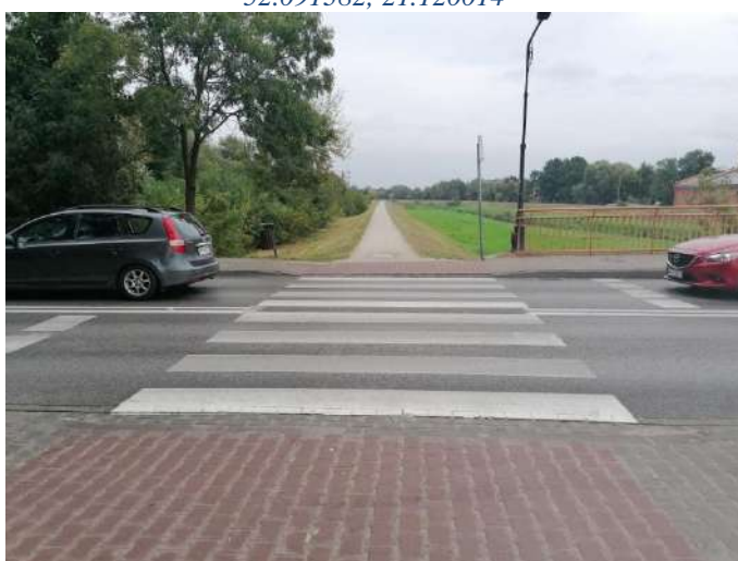
Foto nr 56 [w kierunku północnym] ul. Warszawska wzdłuż Jeziorki [droga dla rowerów i pieszych, nawierzchnia z kostki betonowej– szer. 2,5 m, przejście dla pieszych przez jezdnię, nawierzchnia asfaltowa] 52.091382, 21.120014
