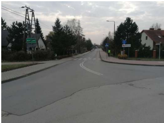
Foto nr 252 [w kierunku południowym] skrzyżowanie ul. Działkowej Skrzyżowanie z ul. Wilanowską [droga dla rowerów i pieszych, nawierzchnia kostka betonowa ] 52.106125, 21.055128
