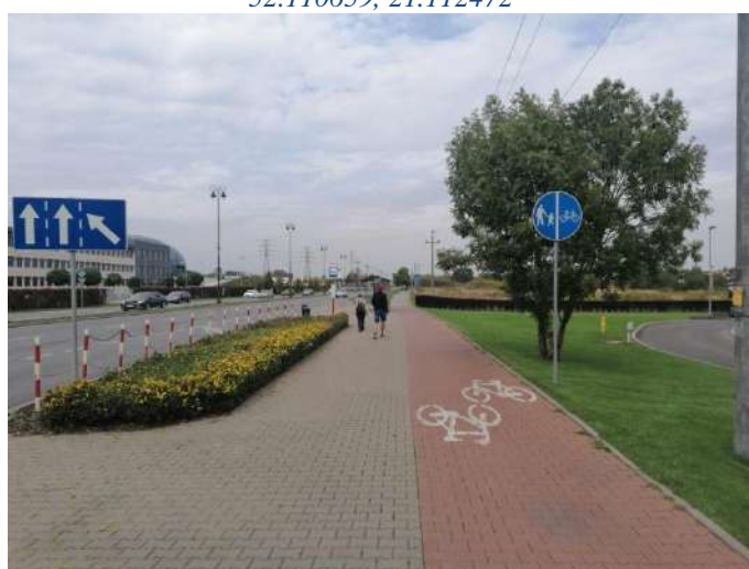
Foto nr 6 [w kierunku północnym] ul. Warszawska [droga dla pieszych i droga dla rowerów, nawierzchnia z kostki betonowej fazowanej szer. – 2,5 m i niefazowanej – szer. 2,0 m] 52.110236, 21.112912
