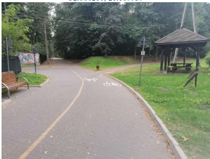
Foto nr 45 [w kierunku południowym] Park Zdrojowy ul. Mostowa – Bulwar skrzyżowanie z ul. Szpitalną [droga dla pieszych i droga dla rowerów, nawierzchnia z kostki betonowej niefazowanej – szer.2,2 m i 2,5 m] 52.082968, 21.104602
