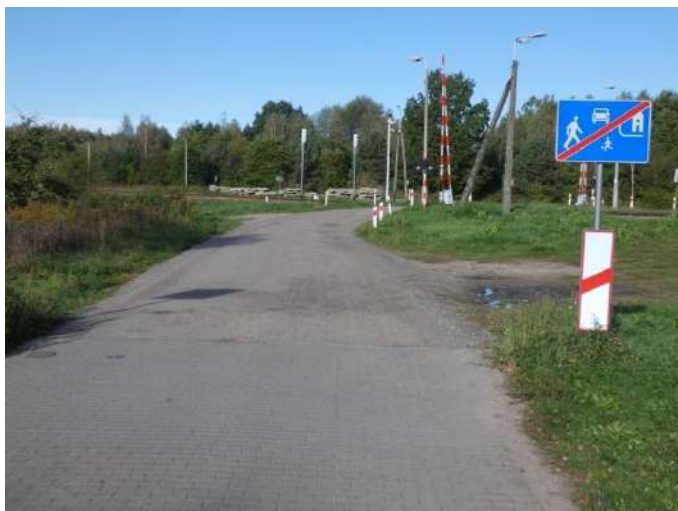
Foto nr 101 [w kierunku północno-zachodnim] ul. Wąska [ruch rowerowy na zasadach ogólnych, nawierzchnia z kostki betonowej niefazowanej] 52.094814, 21.103236
