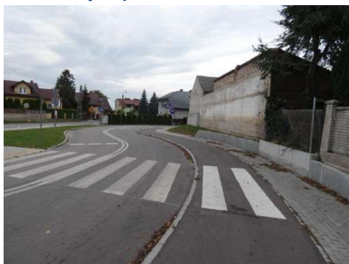
Foto nr 84 [w kierunku północnym] ul. Bociania [droga dla rowerów, nawierzchnia asfaltowa – szer. 1,5 m] 52.108921, 21.131593
