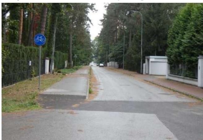
Foto nr 61 [w kierunku północnym] ul. Piaskowa skrzyżowanie z ul. Przesmyckiego [droga dla rowerów, nawierzchnia asfaltowa – szer. 2,0 m] 52.073445, 21.075448
