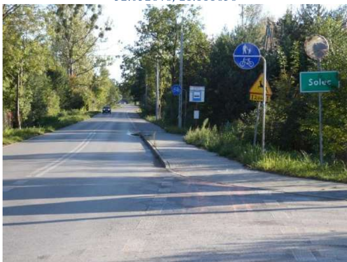
Foto nr 72 [w kierunku południowym] ul. Warecka skrzyżowanie z ul. Zaleśną w kierunku gminy Góra Kalwaria [droga dla rowerów i pieszych – nawierzchnia z kostki betonowej, przechodzi w pas ruchu dla rowerów, nawierzchnia asfaltowa – szer. 2,5 m] 52.052730, 21.111847
