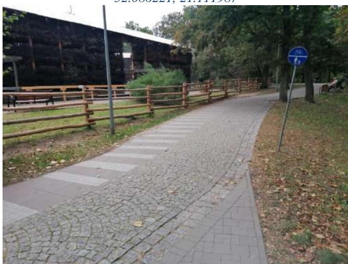
Foto nr 39 [w kierunku zachodnim] Park Zdrojowy na wysokości Tężni Solankowej [droga dla pieszych i droga dla rowerów, nawierzchnia z kostki granitowej – szer. 1,5 m i z płyt granitowych – szer. 1,5 m, nieprawidłowe oznakowanie] 52.086360, 21.113232
