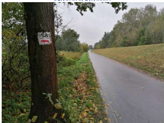
Foto nr 243 [w kierunku północno-zachodnim] droga przywałowa w m. Ciszyca [ nawierzchnia asfaltowa] 52.107209, 21.192076
