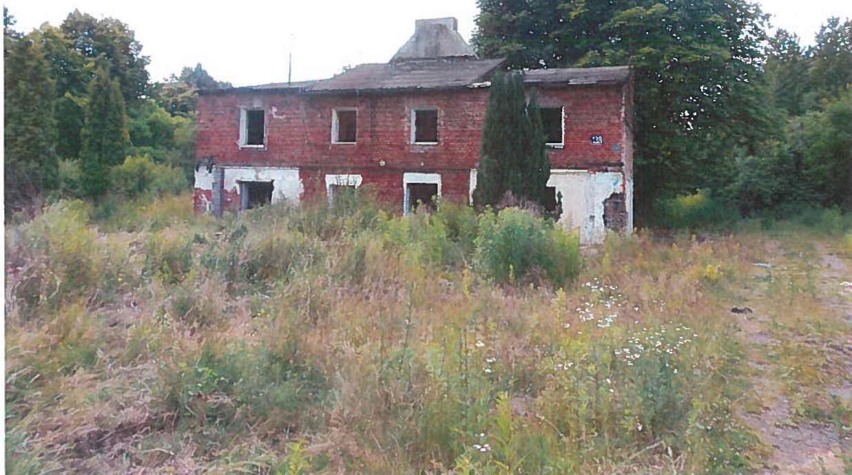
Rys 1; Budynek stanowiący zaplecze dawnej cegielni, rozebrany w 2016 r.
