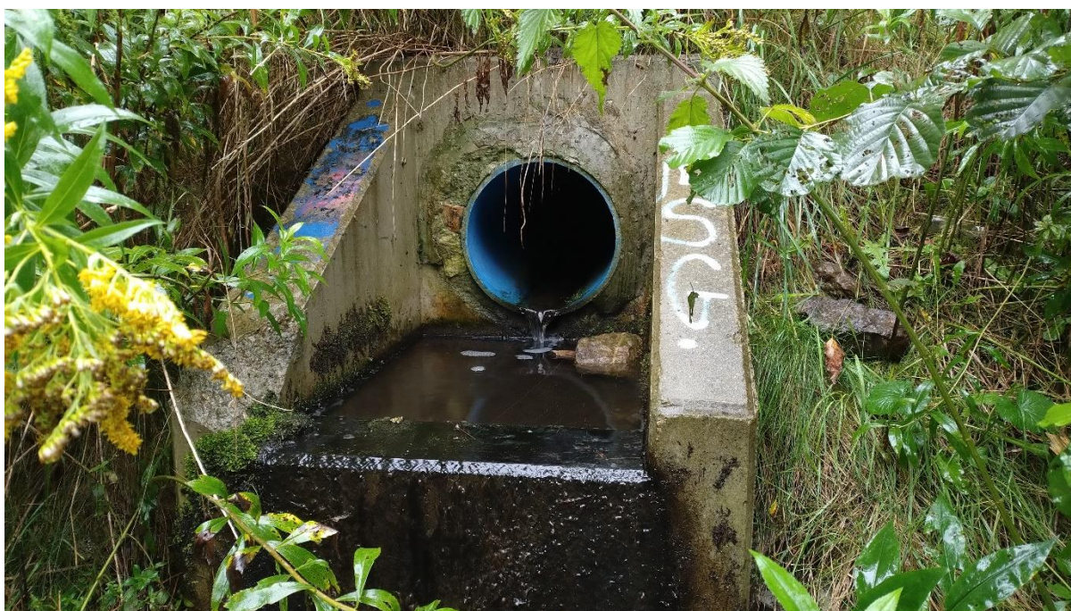
Fot. 3 Wylot kolektora deszczowego z ul. Grechuty/Przesmyckiego.
